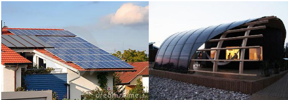
Imagen 24. Ejemplo de viviendas que utiliza sistemas activos.
