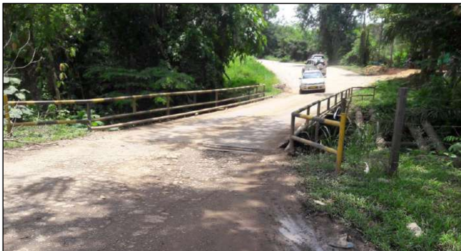
Figura 4. Panorámica Puente 9 Q. Caño Salado
