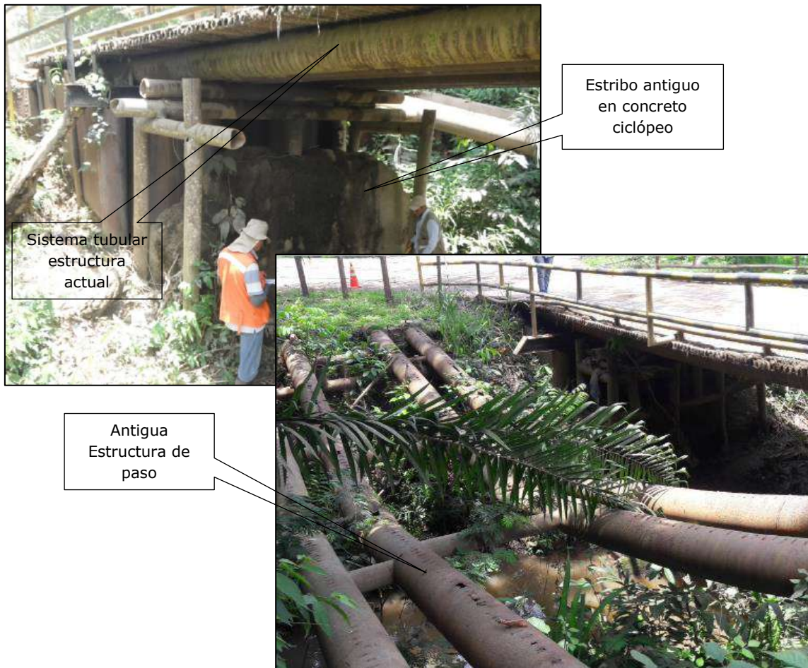
Figura 5. Estado Actual de la Estructura de Paso
