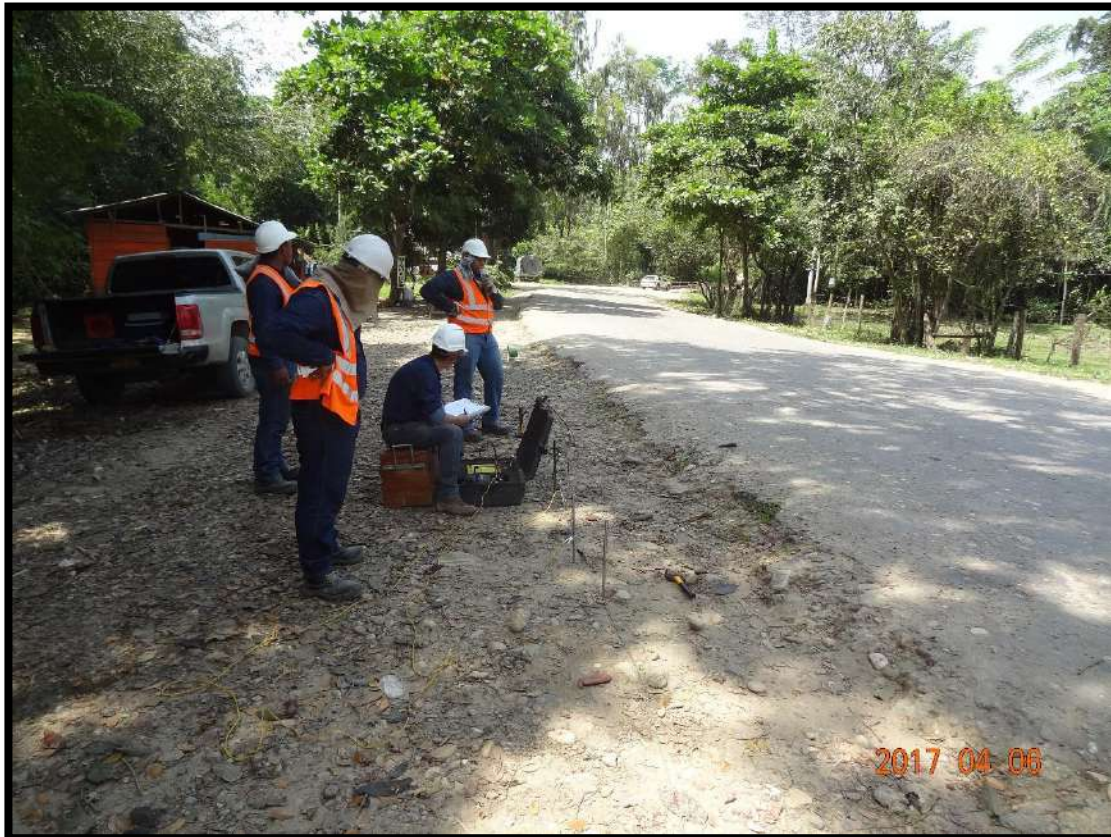
Figura No. 34. Foto del lugar en donde se ejecutó el SEV-10
