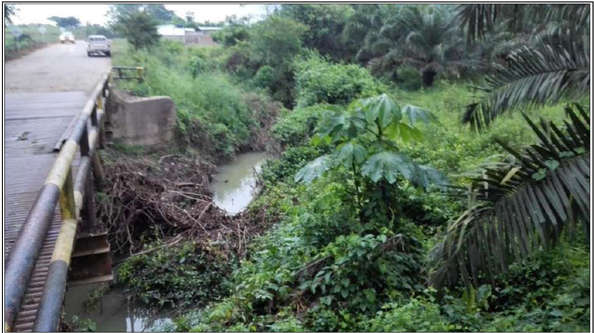
Fotografía 4.1 Aguas abajo Puente 2
