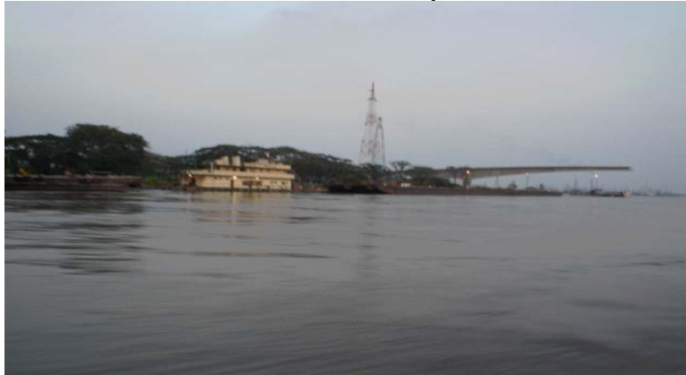
Figura 5. Imagen Construcción Puente Barrancabermeja – Yondó. En la actualidad construcción ya culminada.
