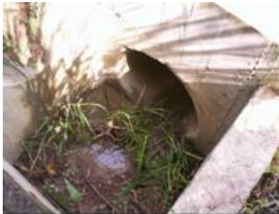
ESTRUCTURA DE ENTRADA
