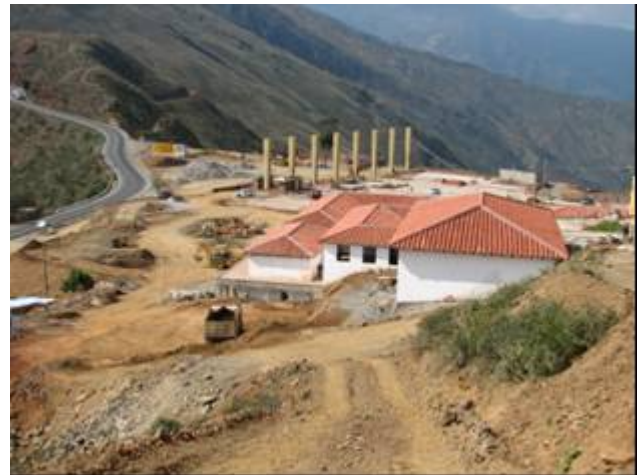
Parque del chicamocha, zona donde se realiza la construcción de museo, capilla, auditorio.
