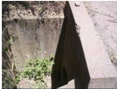
ESTRUCTURA DE ENTRADA
