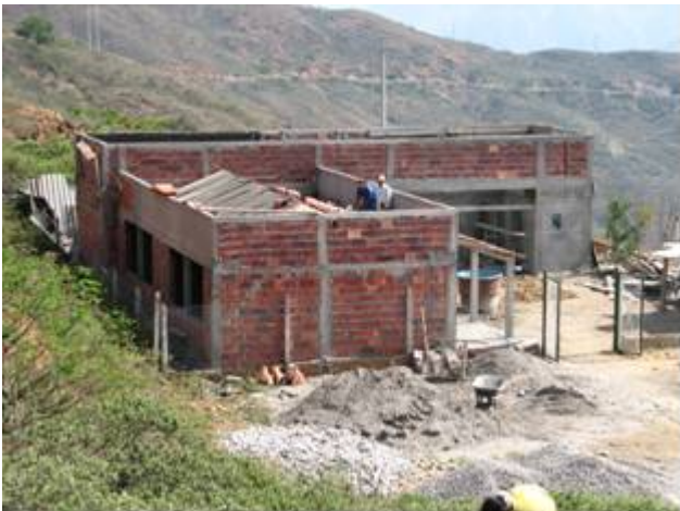
Parque del chicamocha, sitio donde se realiza la construcción de una escuela rural.
