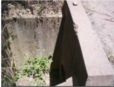
ESTRUCTURA DE ENTRADA
