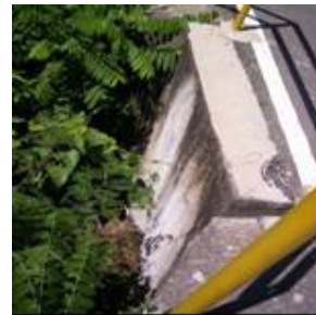
ESTRUCTURA DE SALIDA
