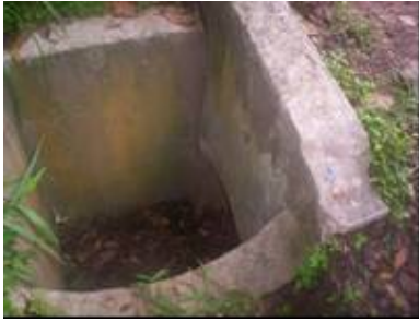
ESTRUCTURA DE ENTRADA
