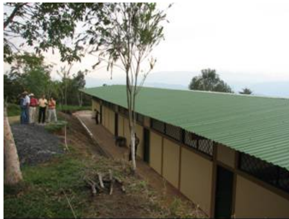
Construcción de aulas escolares en el municipio de suaita.
