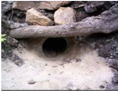
ESTRUCTURA DE ENTRADA
