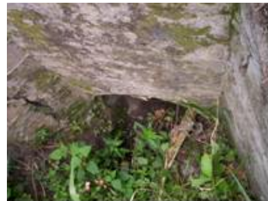
ESTRUCTURA DE SALIDA
