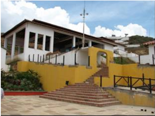
Parque del chicamocha, sitio donde se realiza la construcción de una plazoleta.
