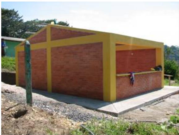
Construcción de aula escolar en el municipio de suaita.
