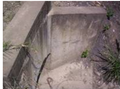
ESTRUCTURA DE SALIDA
