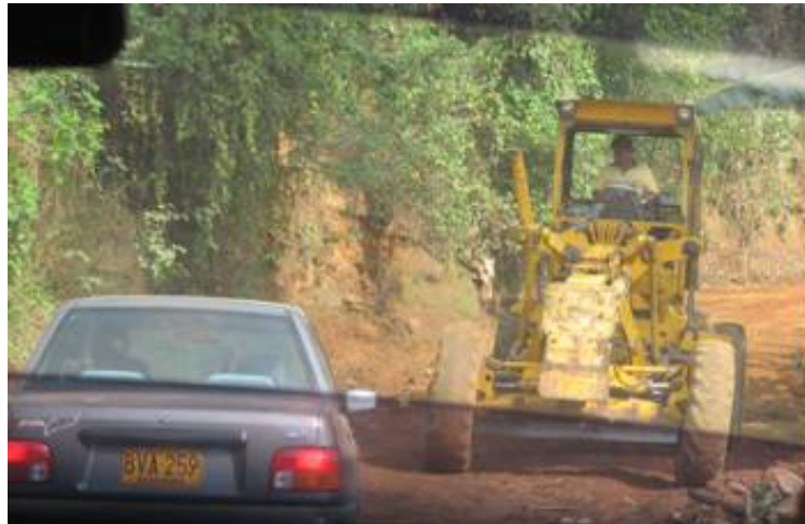
Visita a la obra de mejoramiento via curiti – balneario .
