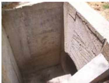
ESTRUCTURA DE ENTRADA
