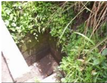
ESTRUCTURA DE ENTRADA
