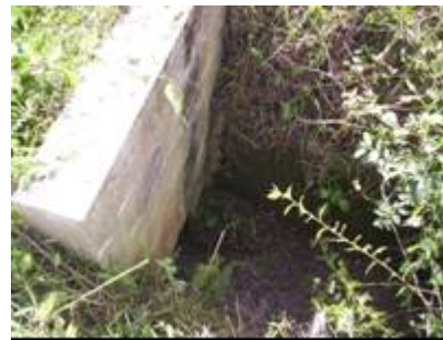
ESTRUCTURA DE SALIDA
