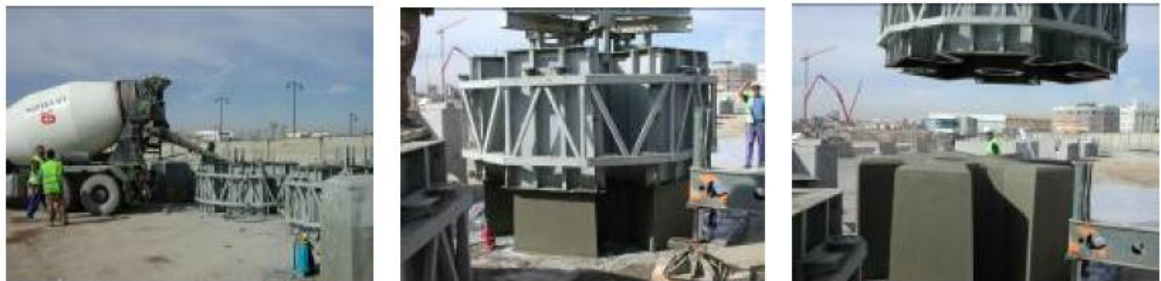
Figura 30. Proceso Constructivo de un Bloque Atamán.
