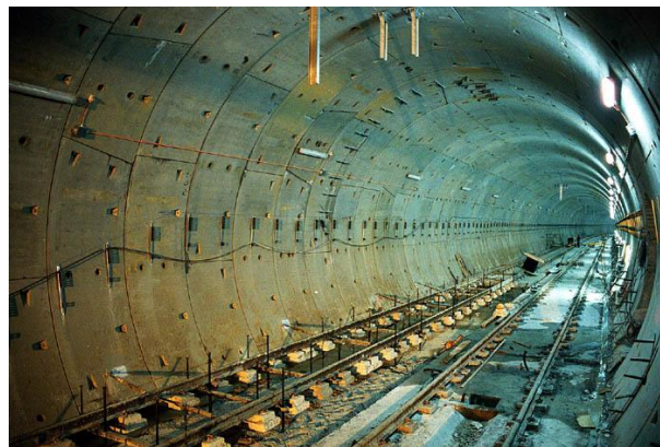
Figura 3. Dovelas ejecutadas por tuneladora.
