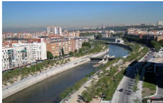
Figura 12. M-30 después del soterramiento.
