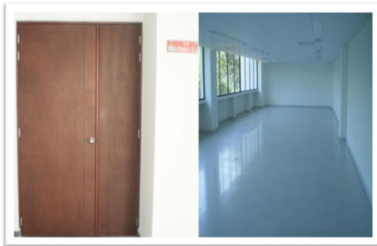
Figura 15. Área destinada al laboratorio
