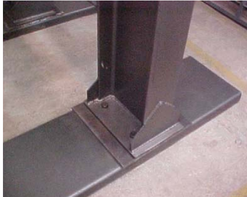
Figura 93. Detalle del anclaje del marco vertical
