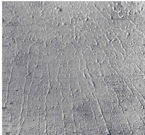
Figura 65. Deshumectación de la capa de Estaño
