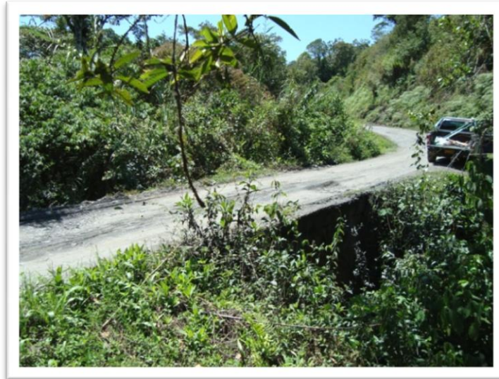
La imagen corresponde al registro de un puente sobre la vía velez guavata
