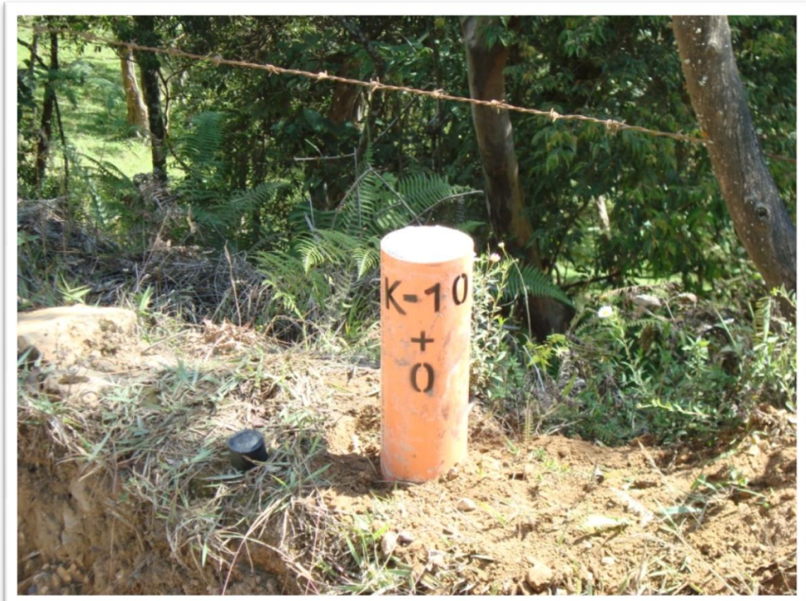
La imagen corresponde al mojón de referencia K10+000 ya instalado y marcado
