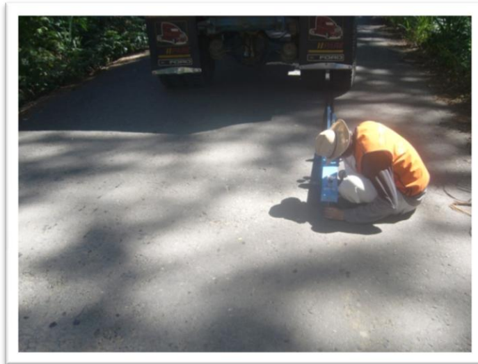
La gráfica hace referencia al momento en el cual se posiciona y calibra la viga benkelman en la via San vicente- La renta
