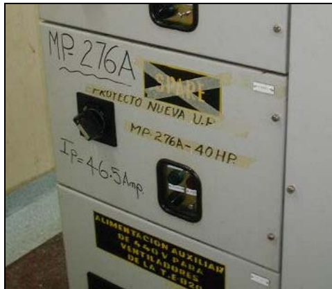
Figura 16. Fotografía de una casilla con el tag desactualizado
