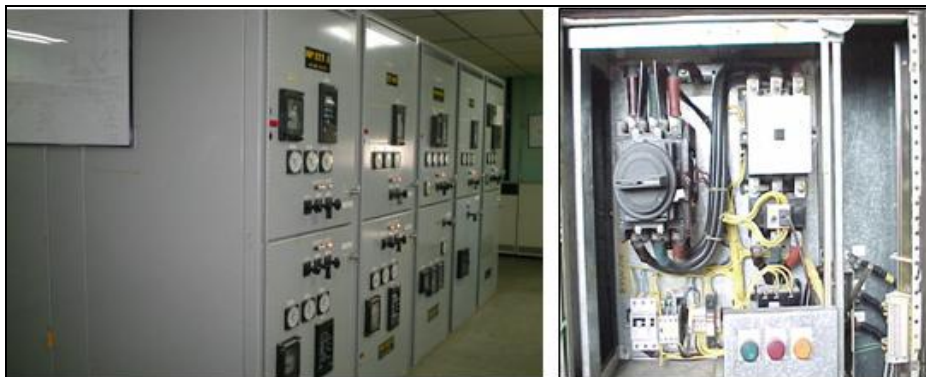
Figura 14. Fotografía de un switchgear (izq.) y fotografía de una casilla de media tensión (der.)
