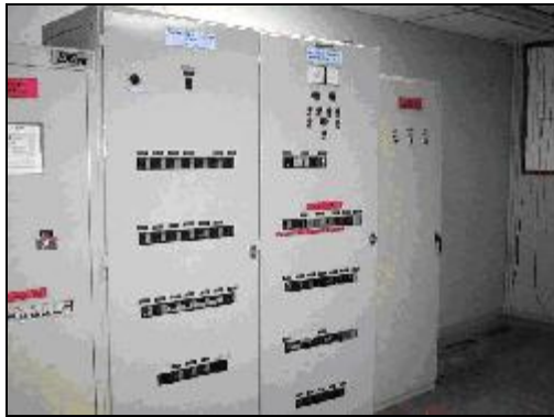
Figura 15. Fotografía de un TSG, un TCC y un ATS
