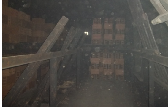
Figura 6: Nave de secado LADRILLOS Y ACABADOS S.A.S en el interior
