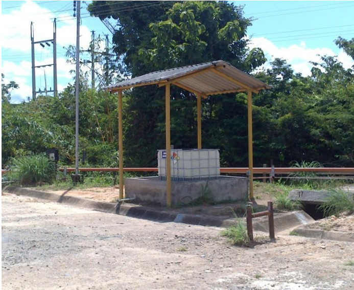
Figura 13. Caseta de químicos
