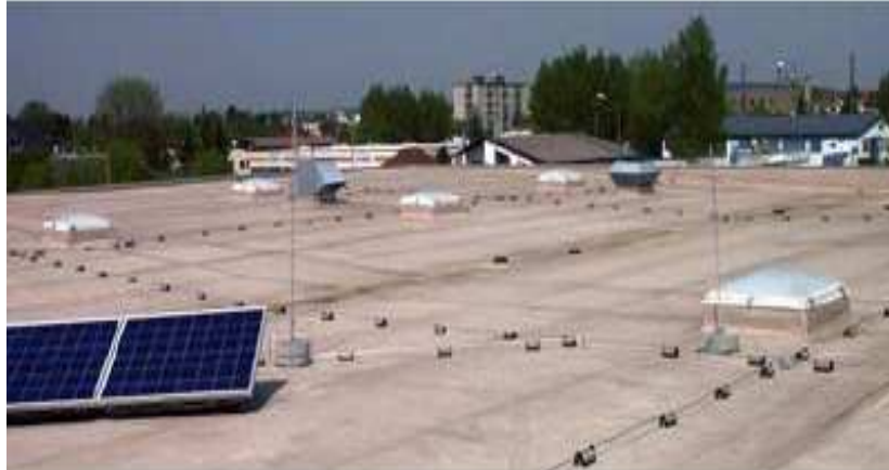
Figura 77. Instalación sistema de captación
