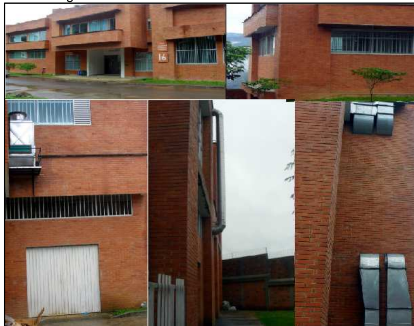
Figura 78. Fachadas edificio Álvaro Beltrán Pinzón
