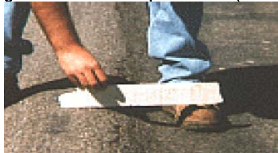
Figura 4. Rodera en un pavimento en servicio
