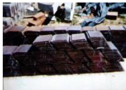
La teja se arregla antes de subirla a la cubierta, se le atraviesa el alambre por la parte superior izquierda donde tiene un oficio especialmente para eso, la teja no va unida a la malla si no por una sola parte, lo que hace un poco menos estable la teja.
