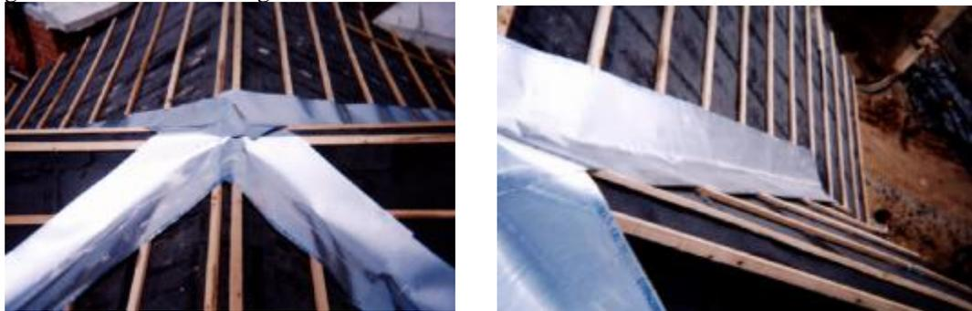
La unión del flanche a las cubierta se hace por medio de puntillas de 2 pulgadas o por grapas metálicas, que van sujetadas a las gabereras externas, los flanches se cortan de 30 a 40 cm. de ancho y su longitud dependerá de la distancia que se quiera canalizar, son de lámina galvanizada y se comercializa en dimensiones de 2m x 1m, con diferente tipo de grosor.
