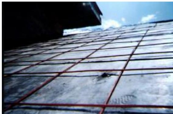
La malla se ubica en la parte superior de la cubierta sobre el manto, y se corta buscando moldear los planos de desagüe, la malla debe ir sujeta a la cubierta por medio de puntillas de 2 o 2½ pulgadas las cuales atraviesan el manto y el machihembre para luego fijarse en las correas, se acostumbra colocar una puntilla cada 3 cuadros, o sea cada dos correas, que se dobla y abraza la varilla de la parte inferior de la cuadrícula. Esto se hace con el fin de fijar la malla a la cubierta.
