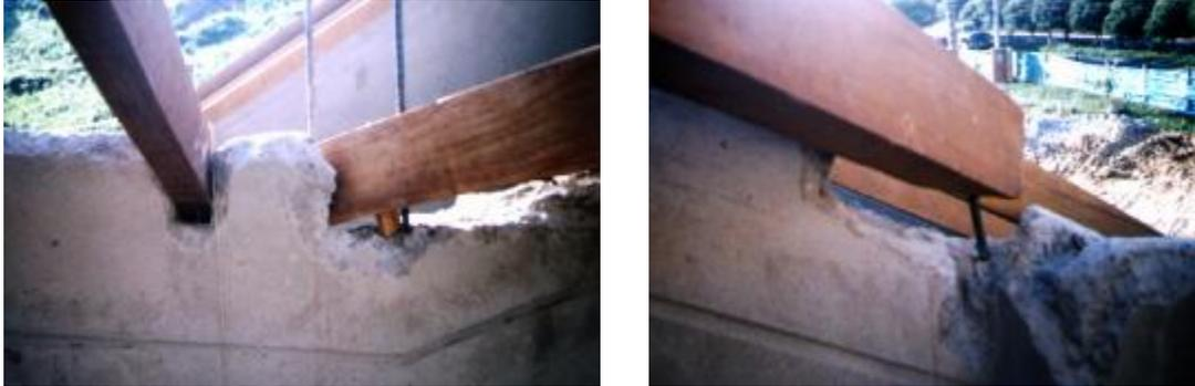
La forma mas utilizada para anclar los elementos en la región es la mencionada anteriormente, pero existe otra forma de anclar los elementos a las vigas de amarre que es muy utilizada en el centro del país, consiste en atornillar alfajías o listones a las vigas de amarre en concreto, para luego apuntillar o atornillar las estructura de la cubierta sobre esta madera.
