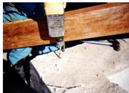
Luego de ubicado el sitio exacto de anclaje, se procede a perforar el concreto en donde ira enterrado el pin, la profundidad del hueco de anclaje estará definida por el peso del elemento que se este anclando y por el sitio donde se va anclar, si es un
