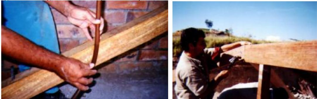
La figura x muestra la forma como se debe apuntillar las vigas secundarias, antes de ser ancladas a las estructuras de concreto, para luego ser colocadas a nivel.
