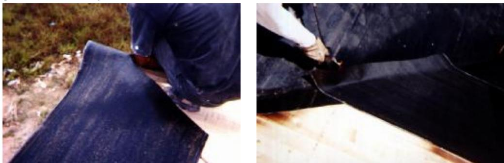
Luego de hacer el corte en forma diagonal se debe hacer la unión con el manto que esta iniciando la impermeabilización del siguiente faldón, esta unión se hace de igual forma como se unen un rollo con el otro, se aplica calor y se pasa una espátula sobre el manto caliente para adherirlo al que esta debajo.
