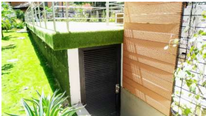
Figura 23. Cuarto de almacenamiento de para residuos peligros de UISALUD
