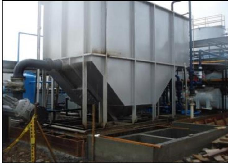
Figura 7. Fotografía del sistema de bombeo de cajilla a CPI.
