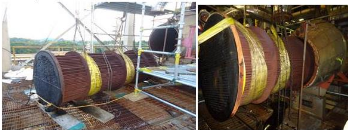
Foto 4. Retiro de haces de tubos
