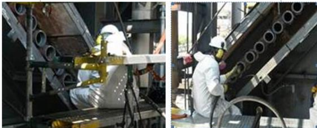
Foto 2. Limpieza a serpentines de Horno H2801 A/B
