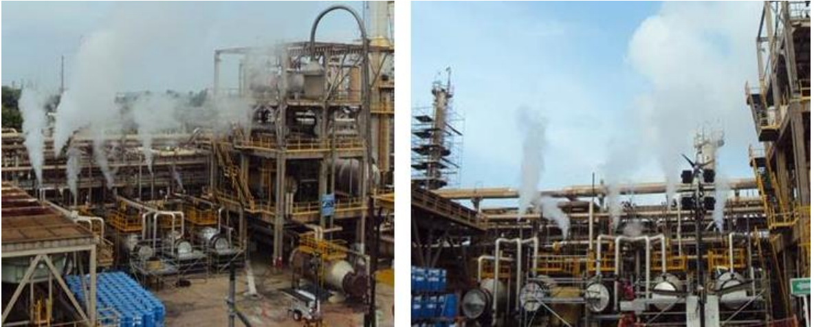
Foto 3. Proceso de Vaporizado Intercambiadores VSKII
