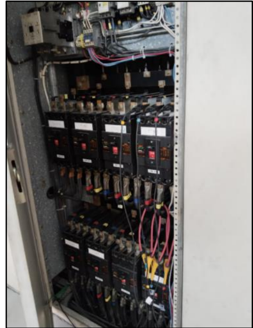
Figura 10 Interior módulo de totalizadores
