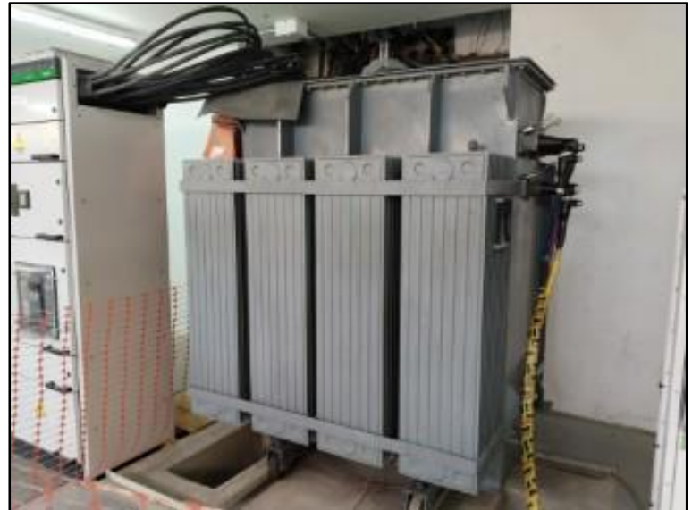
Autor. Transformador en aceite (sin la rejilla de protección)
