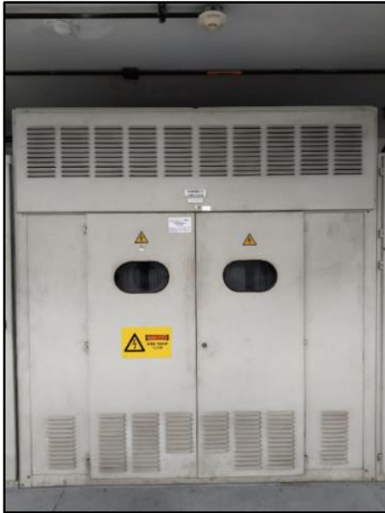
Autor. Transformador en aceite (sin la rejilla de protección)
