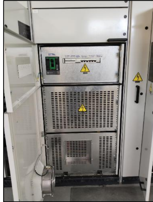
Nota: Cambio de transformador con el mismo servicio
