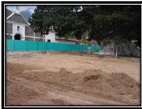
Figura 8. Estado Primer corte de obra – circulación
