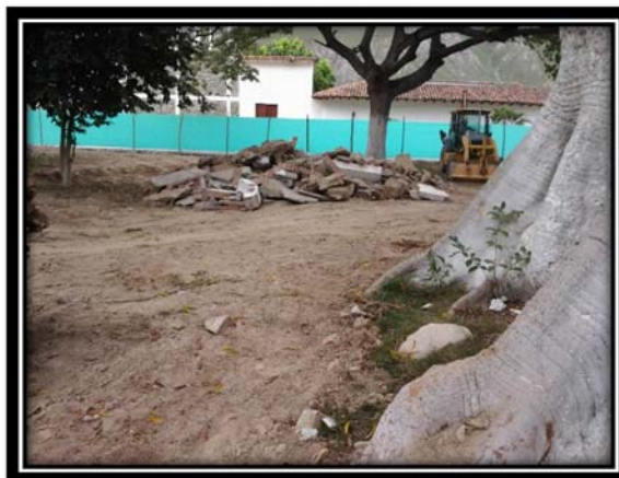
Figura 10. Estado Primer corte de obra – Fuente
