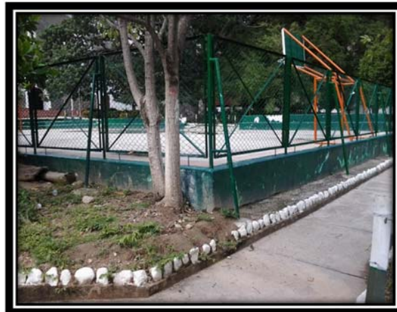
Figura 5. Estado Inicial – Cancha Múltiple
