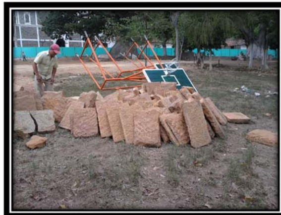
Figura 9. Estado Primer corte de obra – Cancha Múltiple
