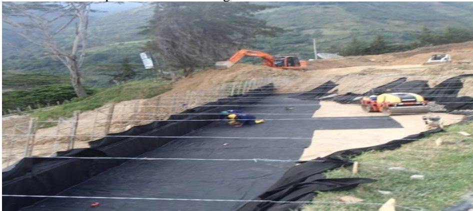
Ilustración 29: Capas de refuerzo con geosintético.
