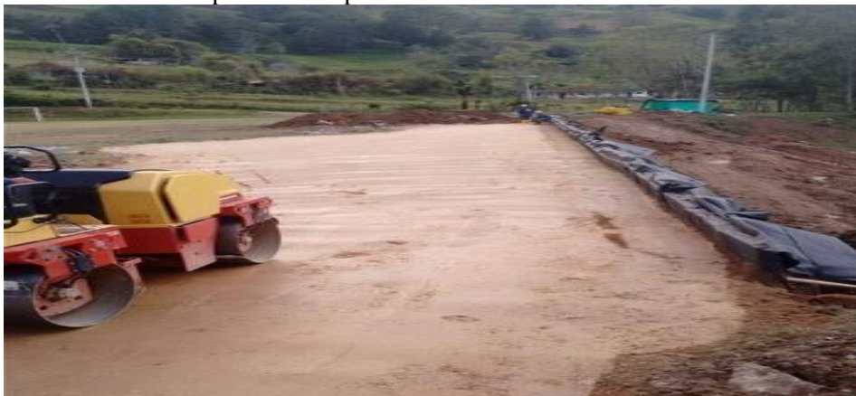
Ilustración 30: Compactación capas de relleno.
