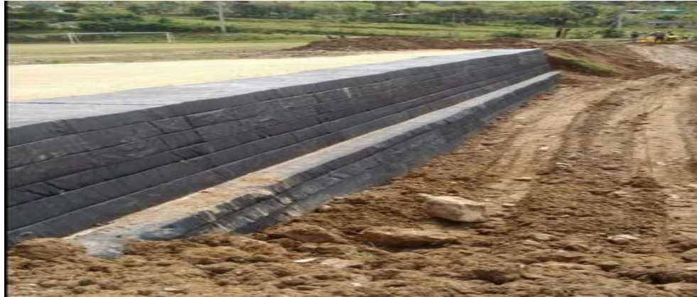
Ilustración 31: Muro de tierra armada - Terminado.
