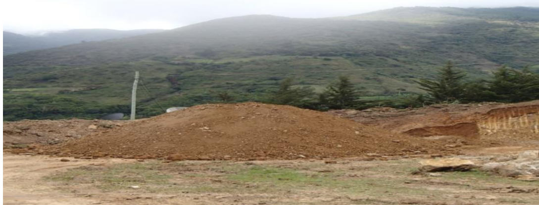
Ilustración 39: Material de suelo seleccionado para capas de relleno.
