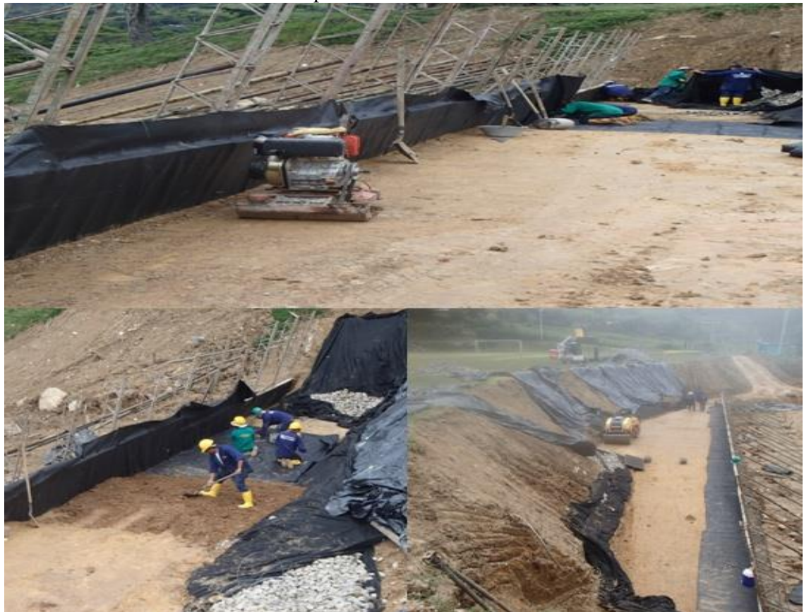
Ilustración 54: Construcción de las capas de relleno.
