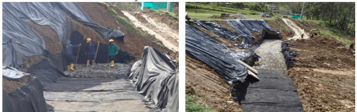
Ilustración 23: Construcción del drenaje.
