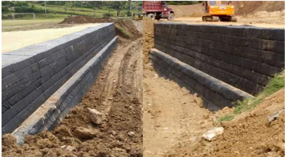
Ilustración 56: Muro en tierra armada con geosintéticos - Terminado
