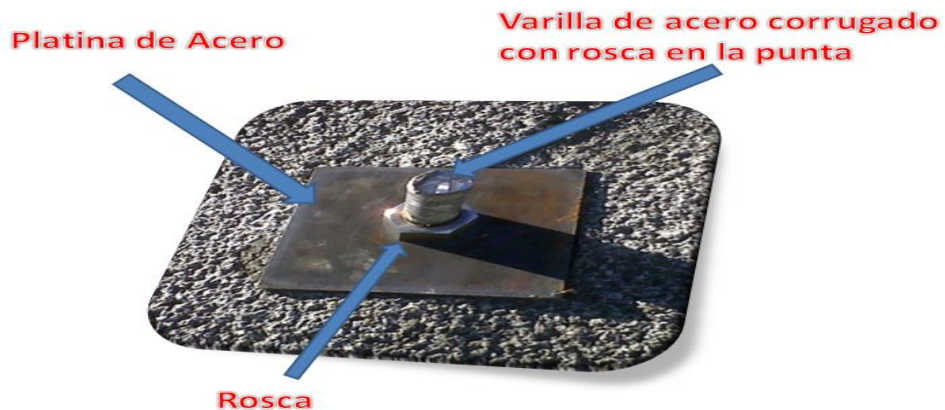
Ilustración 49: Anclaje Pasivo (perno).
