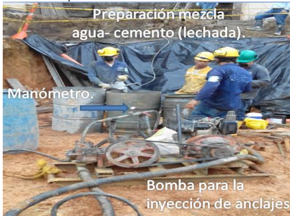
Ilustración 44: Preparación de la Lechada.
