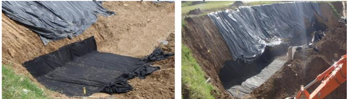
Ilustración 22: Instalación geotextil no tejido para el drenaje.
