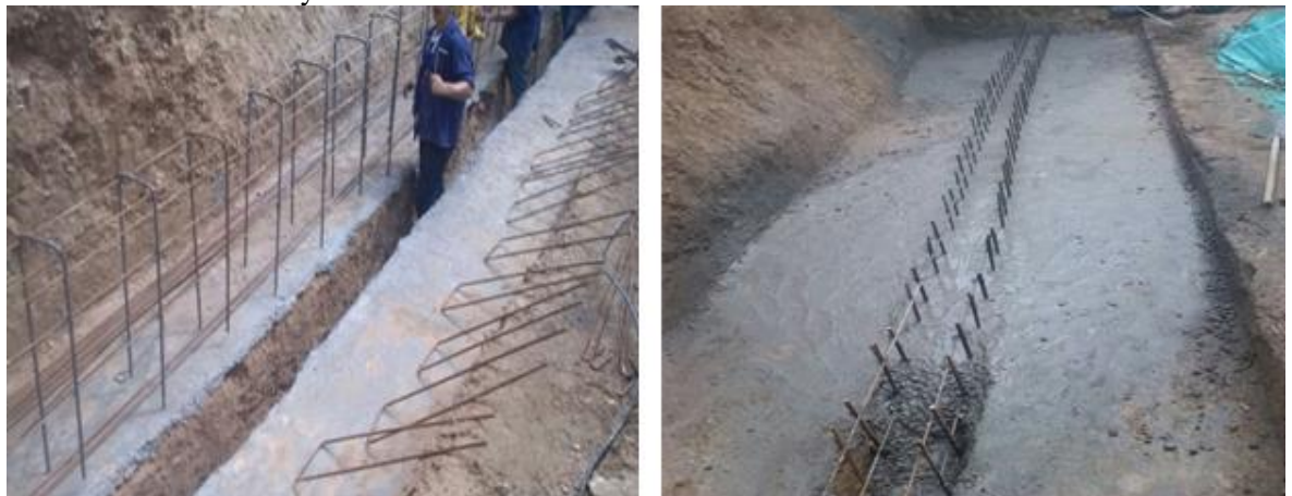
Ilustración 7 : Armado y fundida del dentellón.
