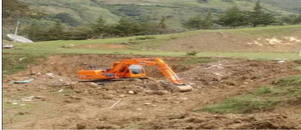
Ilustración 20: Descapote del talud.
