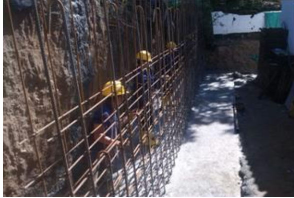
Ilustración 9: Armado y encofrado del cuerpo del muro de contención.
