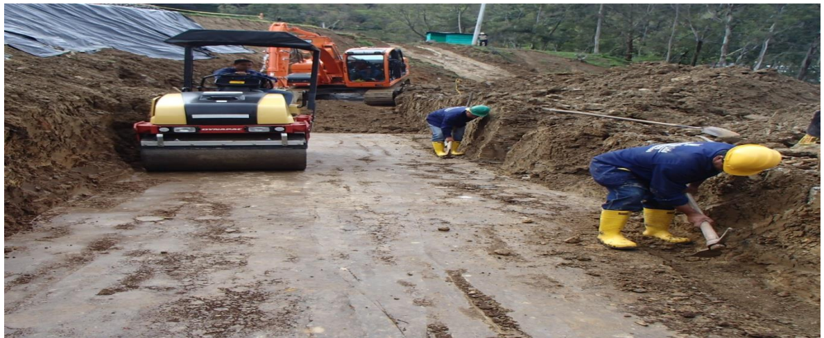
Ilustración 52: Excavación y compactación superficial de la cimentación del muro en tierra armada.
