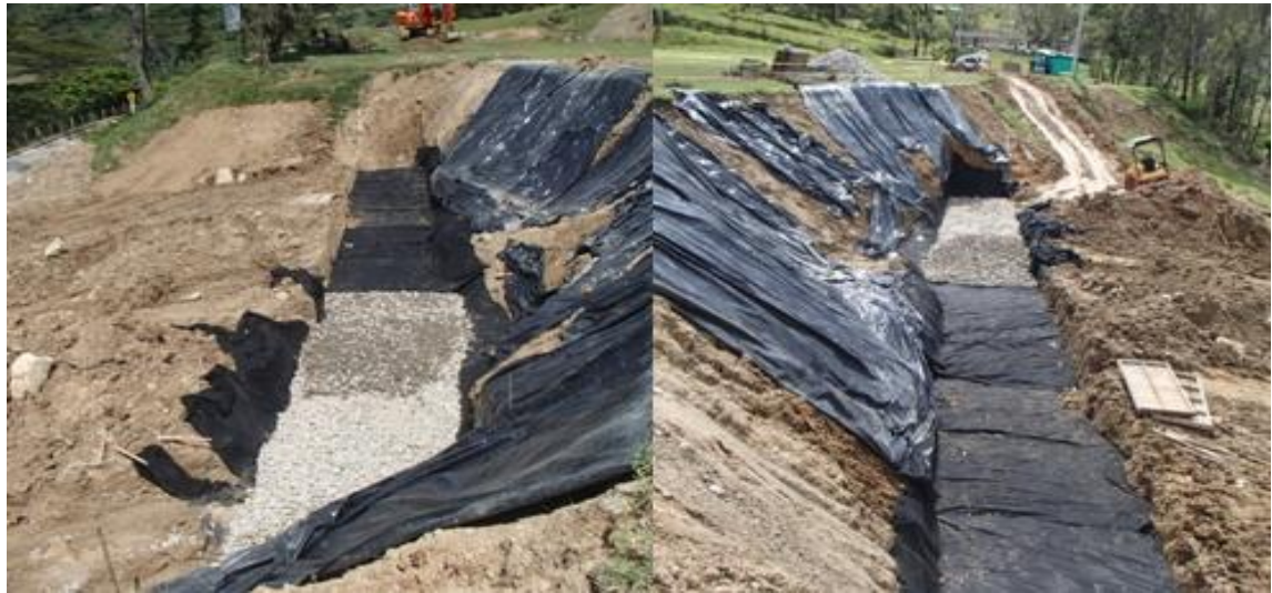
Ilustración 53: Construcción Dren de la base del muro en tierra armada.
