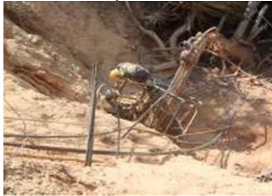
Ilustración 15: Perforación orificio del Anclaje.
