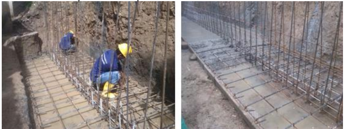
Ilustración 8: Armado y fundida base zapata del muro.
