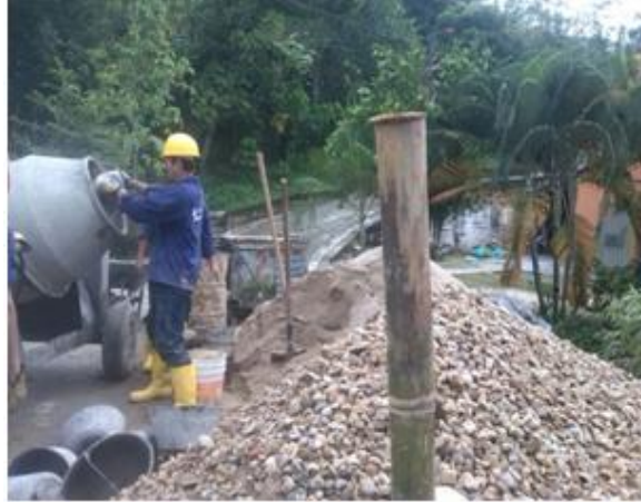
Ilustración 10. Fundida cuerpo del muro de contención.
