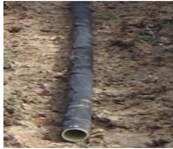
Ilustración 41: Dren - Tubo sanitario revestido con geotextil no tejido.
