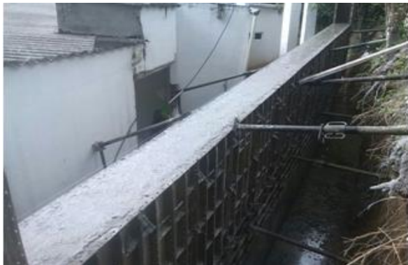
Ilustración 11: Desencofrado del muro.
