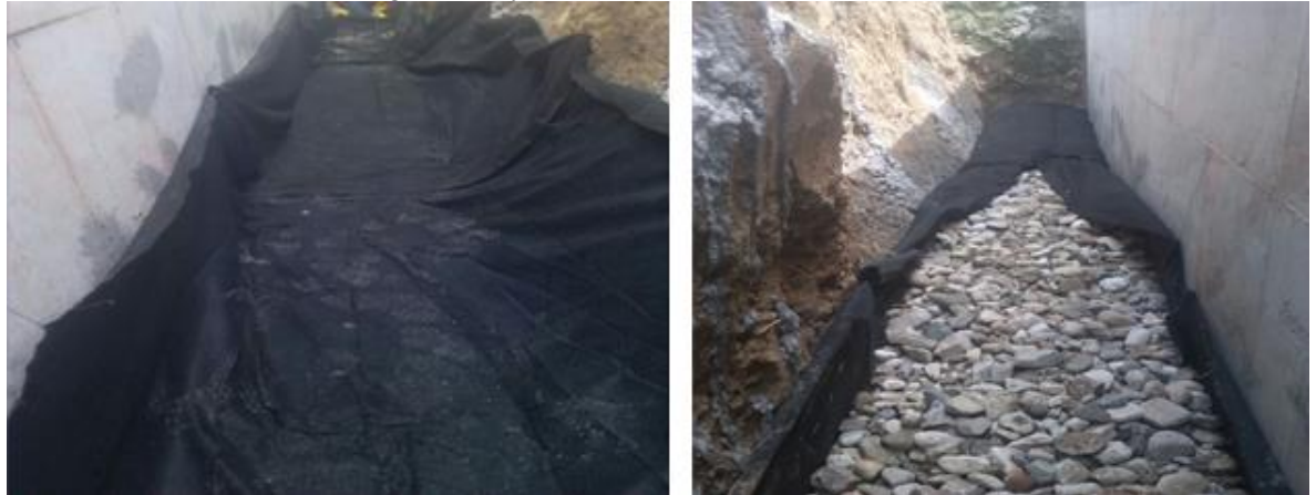
Ilustración 12: Instalación de geotextil y material filtrante.
