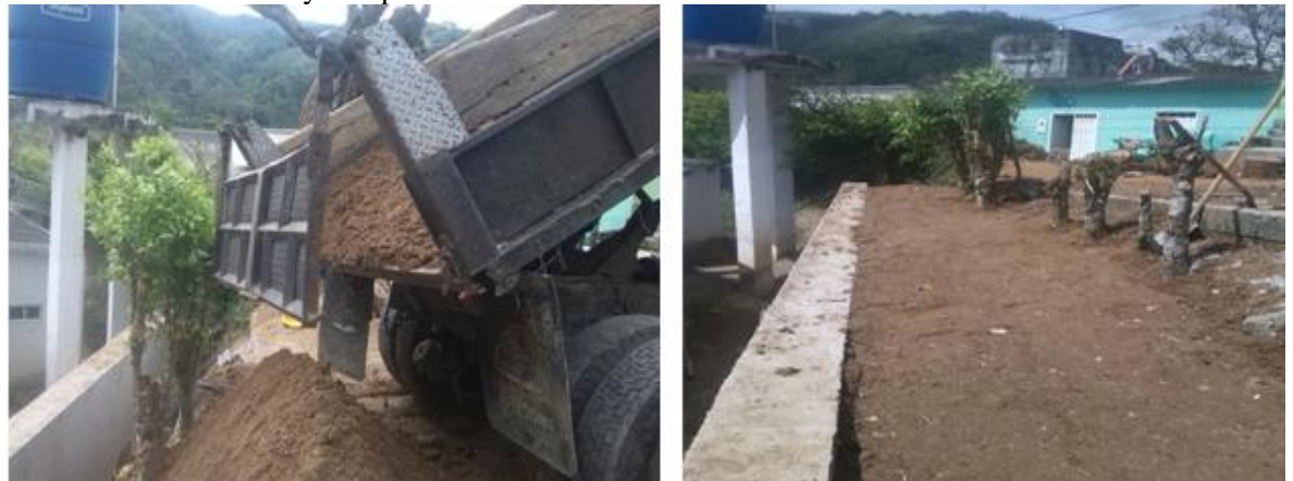
Ilustración 13: Relleno y compactación.
