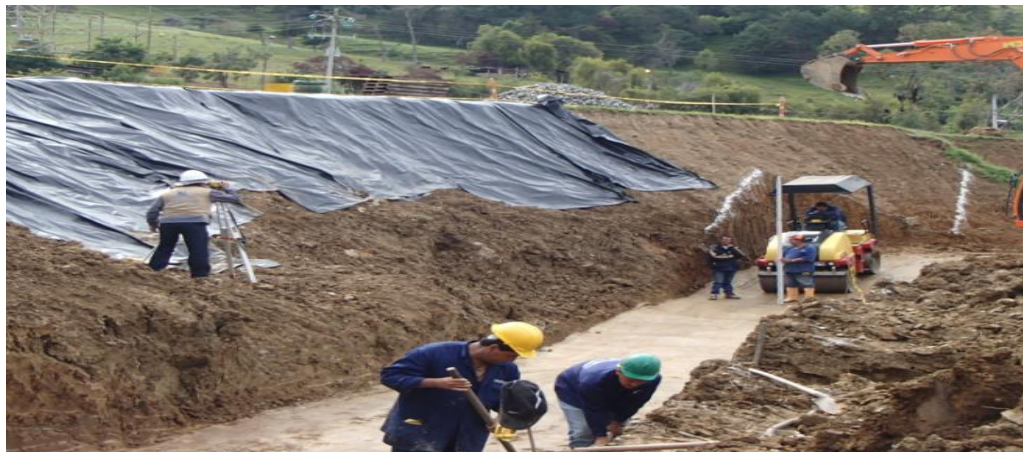
Ilustración 21: Excavación de la cimentación.
