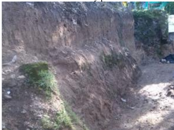
Ilustración 6: Excavación y perfilación del talud.
