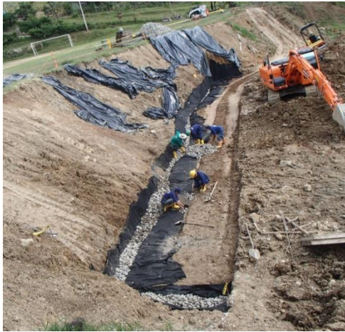
Ilustración 25: Dren detrás del muro.
