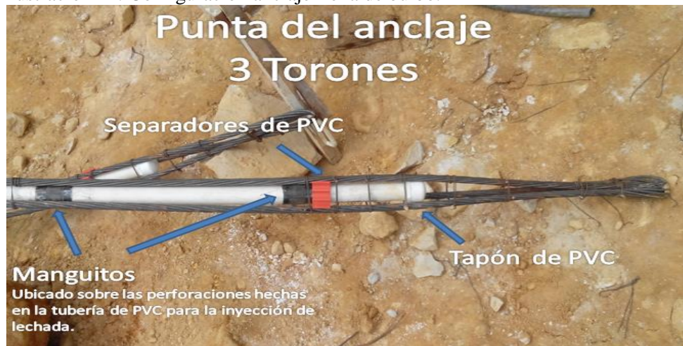
Ilustración 42: Configuración anclaje Zona de bulbo.
