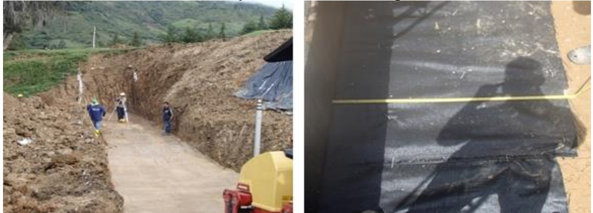
Ilustración 33: Control de excavaciones y medidas de refuerzo del geosintético.
