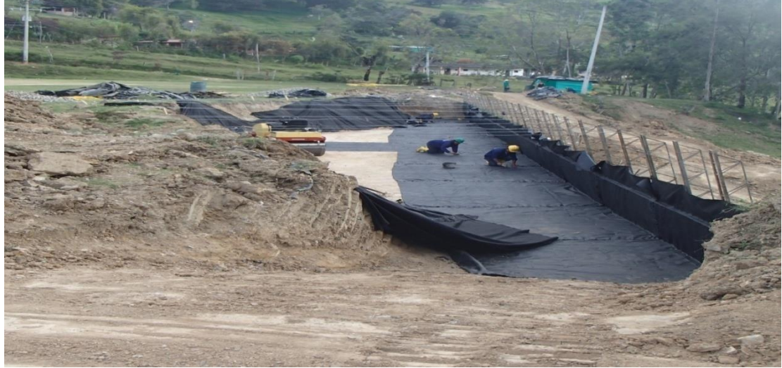
Ilustración 55: Construcción de las capas de relleno con geosintéticos.
