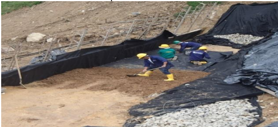
Ilustración 27: Conformación capas de relleno.
