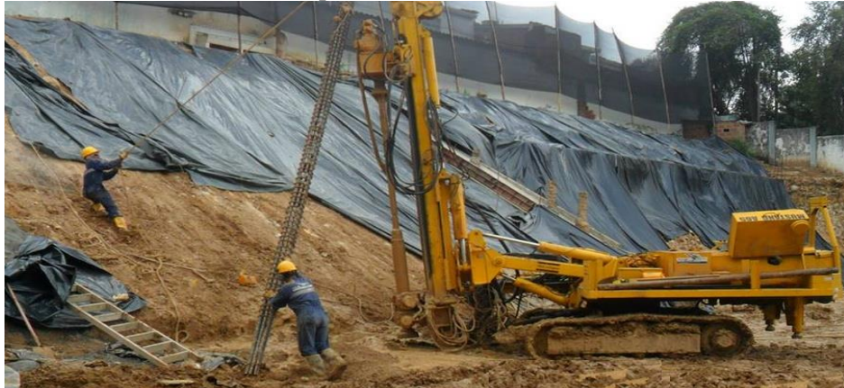
Ilustración 50: Instalación de un Micropilote
