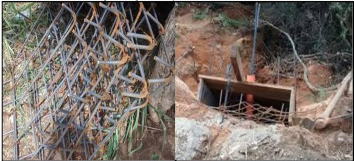
Ilustración 16: Construcción pantalla para anclaje.
