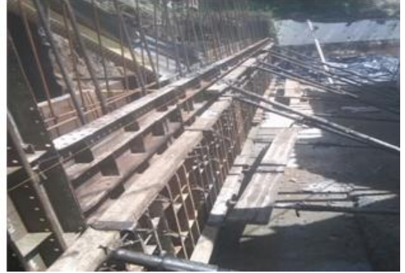
Ilustración 9: Armado y encofrado del cuerpo del muro de contención.
