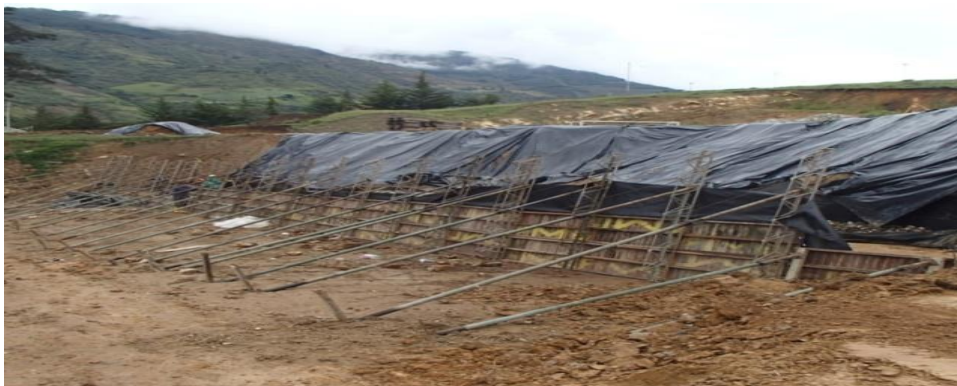
Ilustración 26: Conformación frontal del muro.
