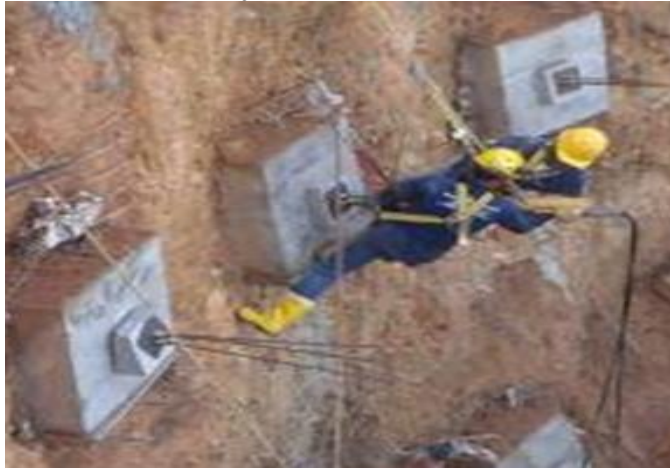
Ilustración 17: Tensionamiento del anclaje.
