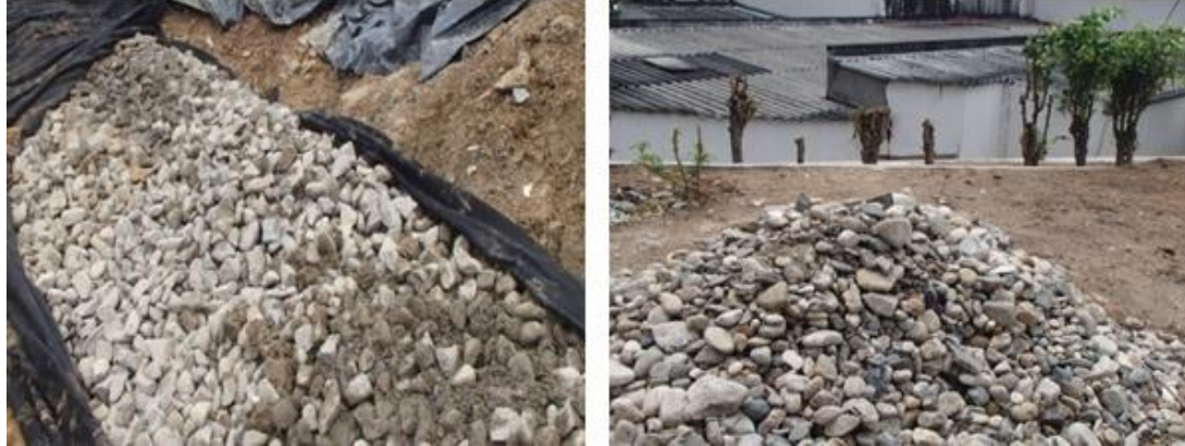
Ilustración 38: Material granular para filtro.
