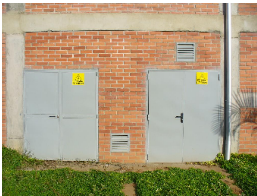
Figura 1.3 Subestación capsulada
