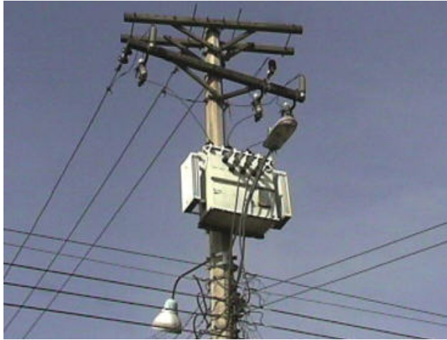
Figura 1.1 Subestación aérea
