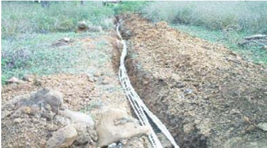
IMAGEN 10. Instalación y tendido de las redes domiciliarias.
