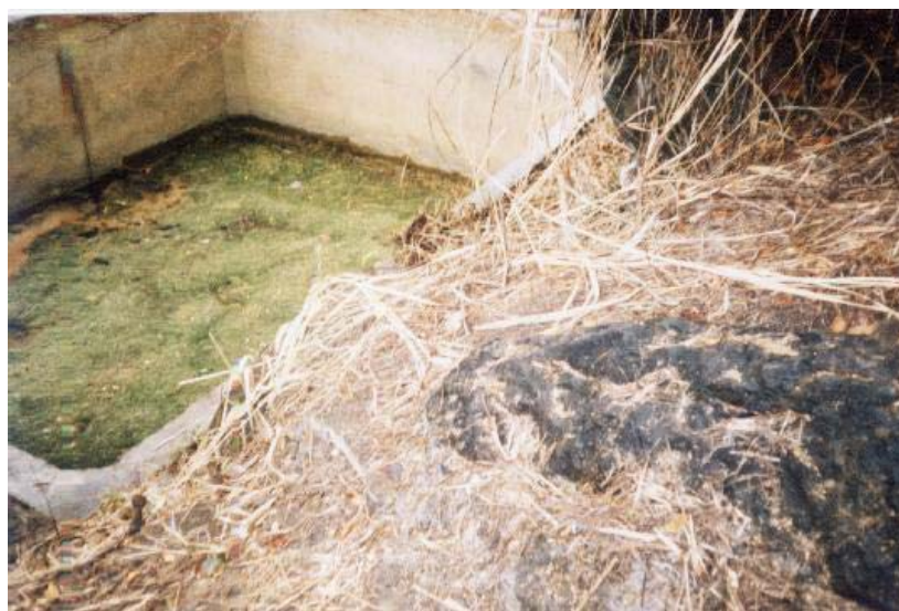
IMAGEN 2. Estado original del Tanque No. 2
