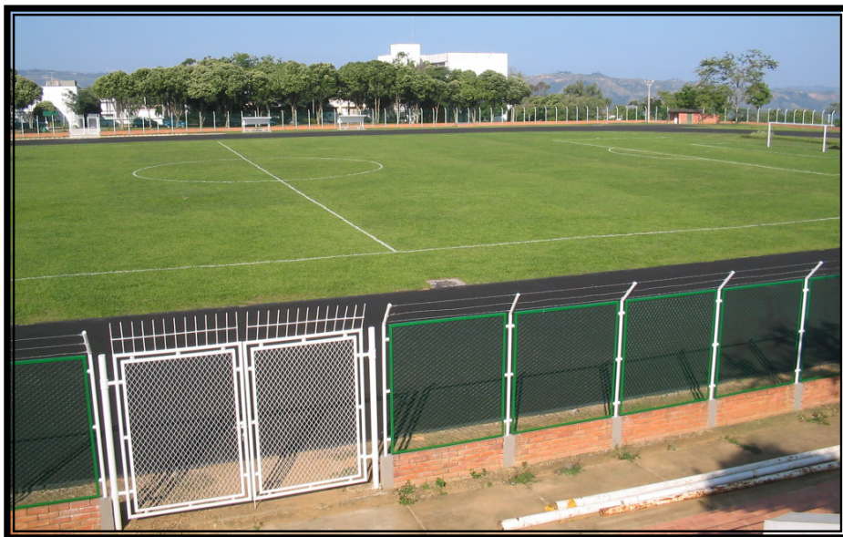
Foto 33. Estadio 1 de Marzo; Registro fotográfico de entrega de Obra.
