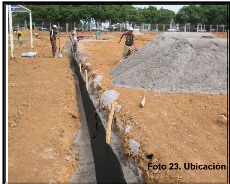
Foto 22. Detalle ensamble de Geodren
