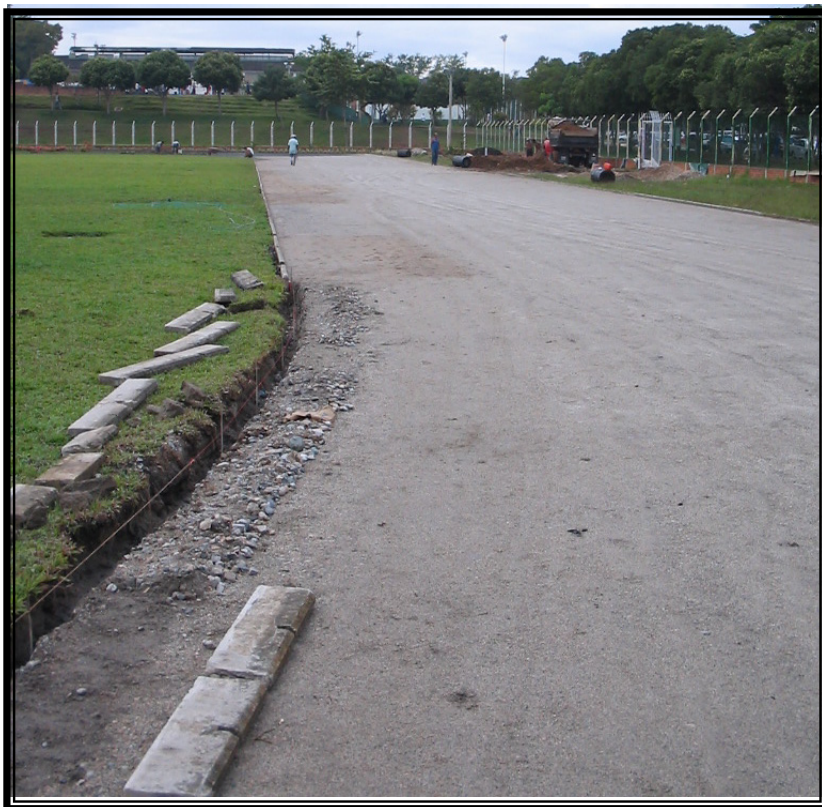
Foto 27. Reparación bordillos de la pista atlética.
