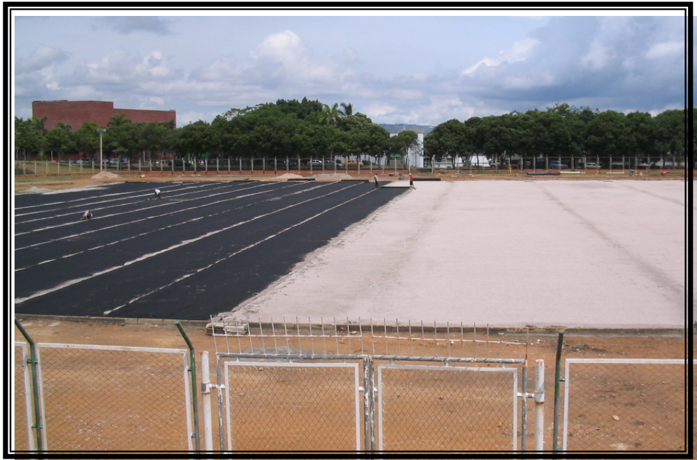
Foto 25. Sistema de Filtros y Drenajes instalación
