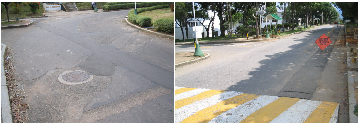
Foto 1. Malla Vial Perimetral UIS, después de trabajos Red Hidráulica.(2005)
