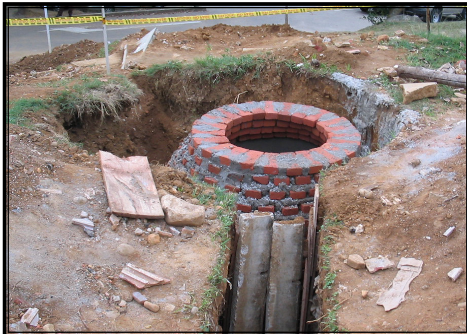
Foto 19. Detalle construcción de pozo de inspección
