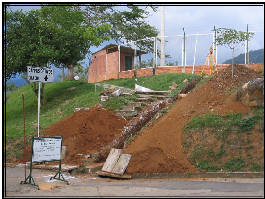
Foto 17. Detalle zanja para tubería de 12pul.
