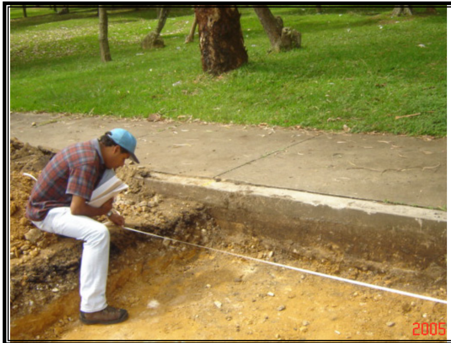
Foto 5. Medición de cajas ó zonas a reparar.
