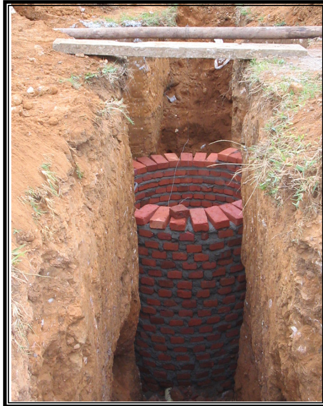
Foto 18. Detalle construcción de pozo de inspección
