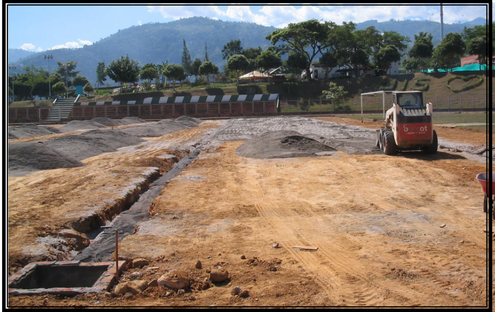
Foto 24. Detalle Llegada de Geodren
