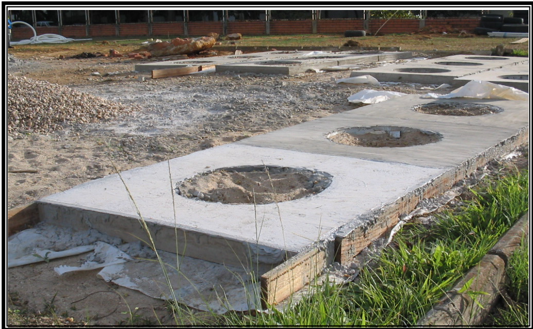
Foto 26. Detalle construcción tapas pozos de inspección
