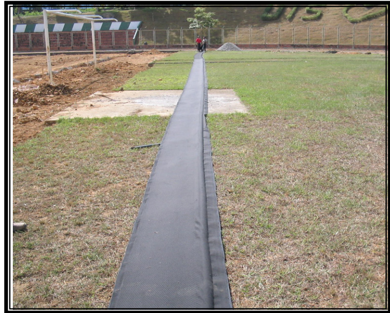
Foto 22. Detalle ensamble de Geodren
