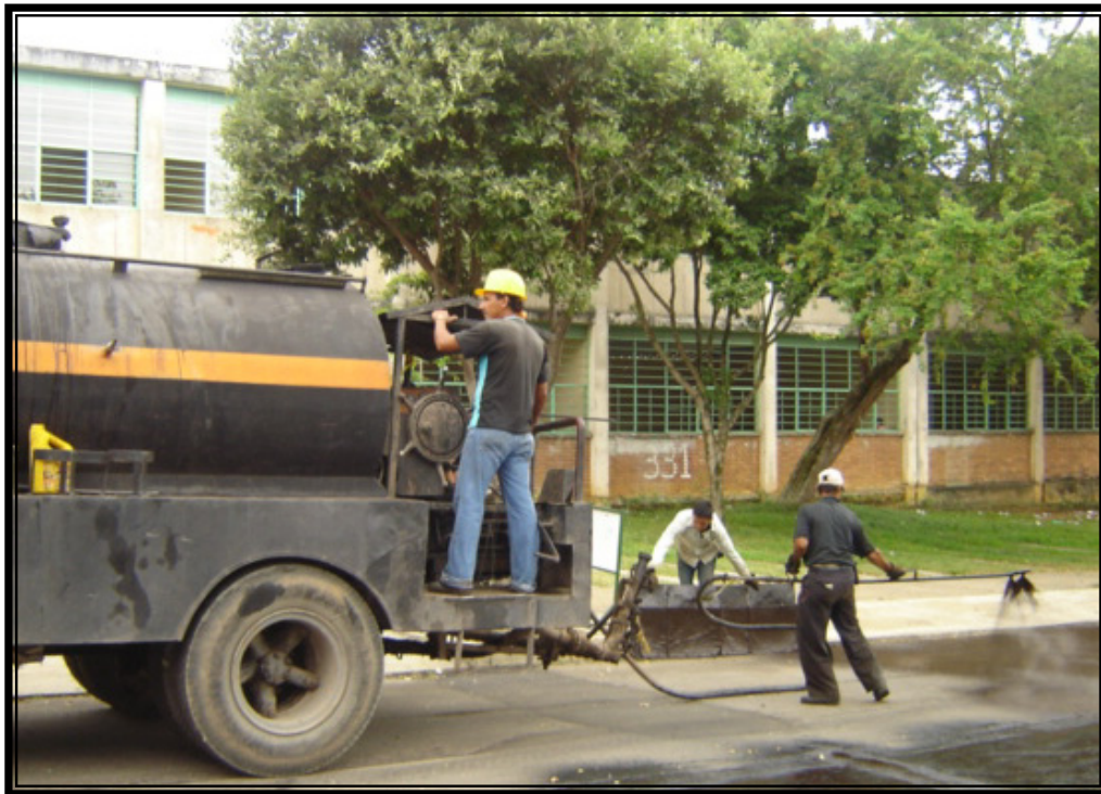
Foto 13. Detalle aplicación material ligante sobre la vía.
