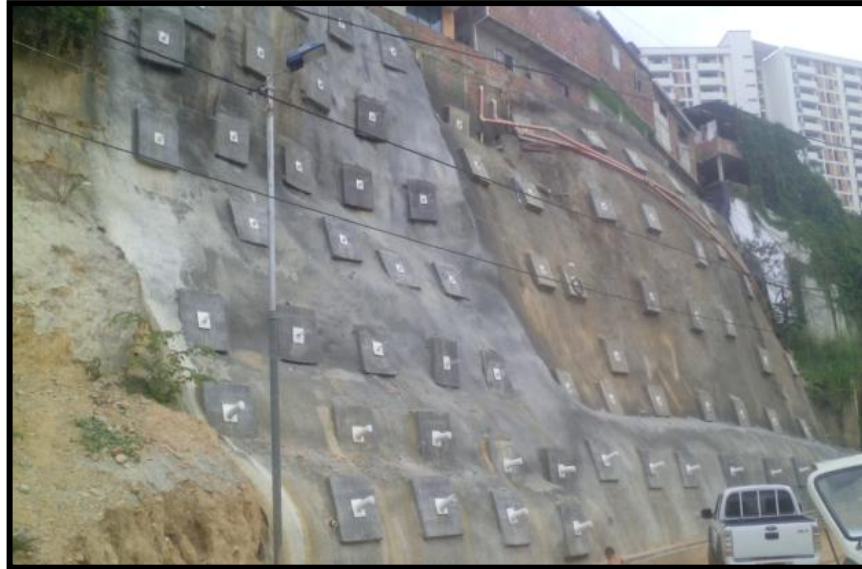
Figura 6. Vista pantalla anclada en Concreto Lanzado localizada en el Barrio Granjas de Provenza del Municipio de Bucaramanga, Contrato No. 9235-01.
