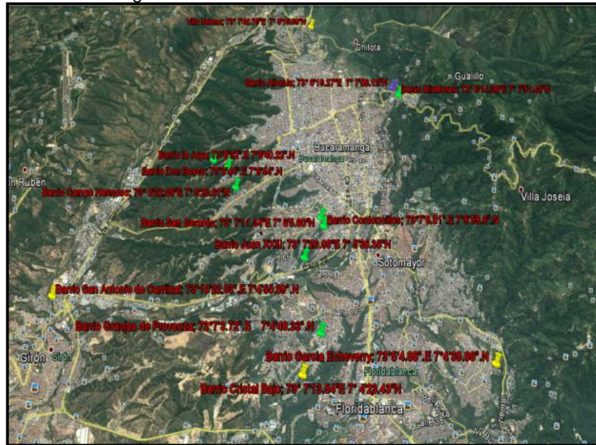
Figura 9. Localización Geográfica de algunas obras realizadas a lo largo de toda el Área metropolitana de Bucaramanga.
