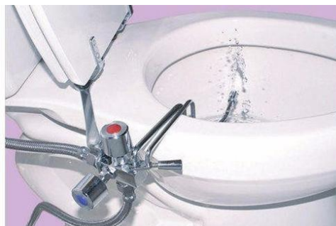
Figura 21. Dispositivo instalado en inodoro.
