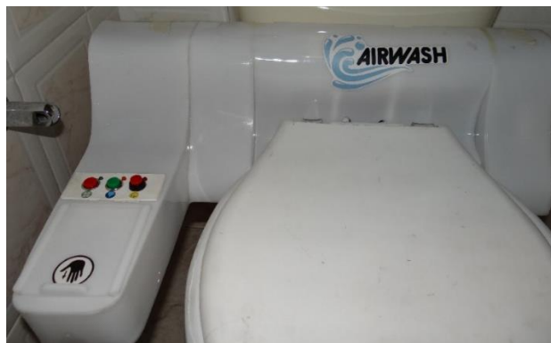
Figura 106. Carcasa y unidad técnica del sistema de higiene personal.
