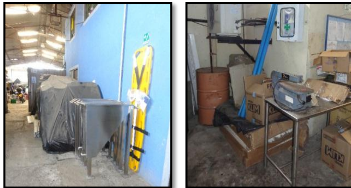
Ilustración 24. Acceso a camilla de evacuación y botiquín
