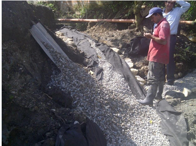
Figura 4: Fotografía conformación de filtro
