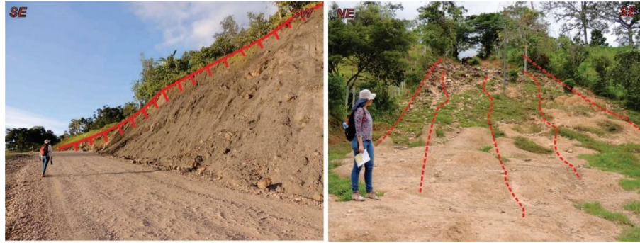
Figura 18. Deslizamiento compuesto en el sector Peña de Oro. La imagen de la derecha las líneas rojas indican surcos formados sobre un cono de deslizamiento antiguo.
