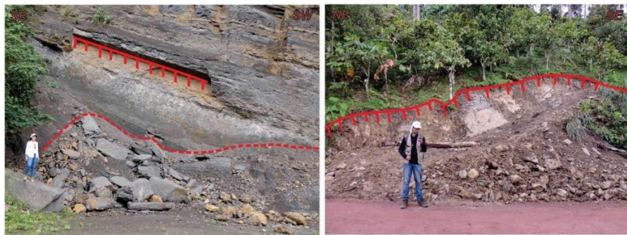
Figura 16. Caída de roca y deslizamiento traslacional sobre la vía San Vicente de Chucurí- Zapatoca.
