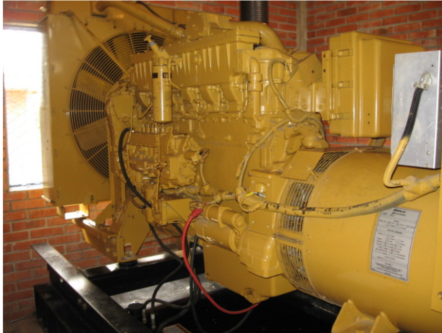
Figura 9. Generador Diesel
