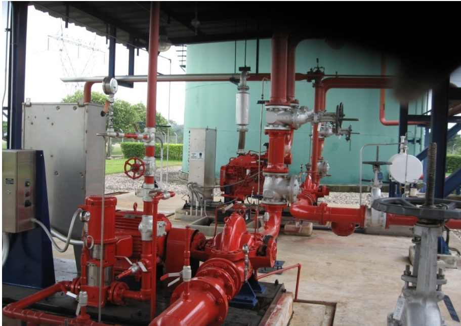
Figura 10. Red de distribución de Sistema Contra incendio
