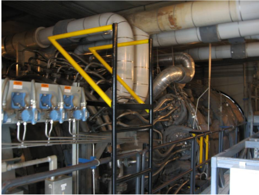
Figura 5. Turbina de combustión
