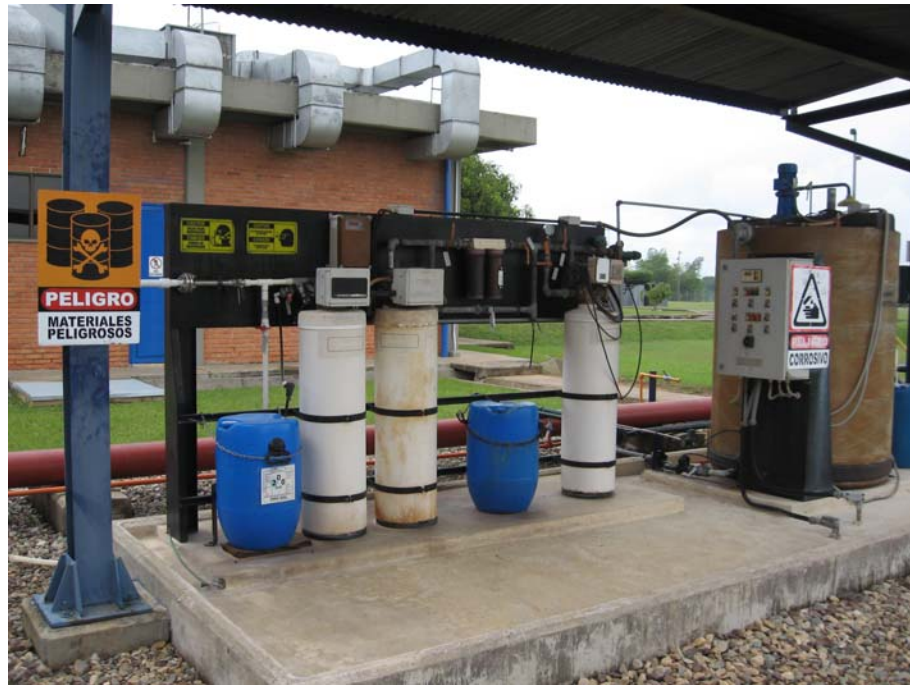
Figura 12. Sistema de agua desmineralizada
