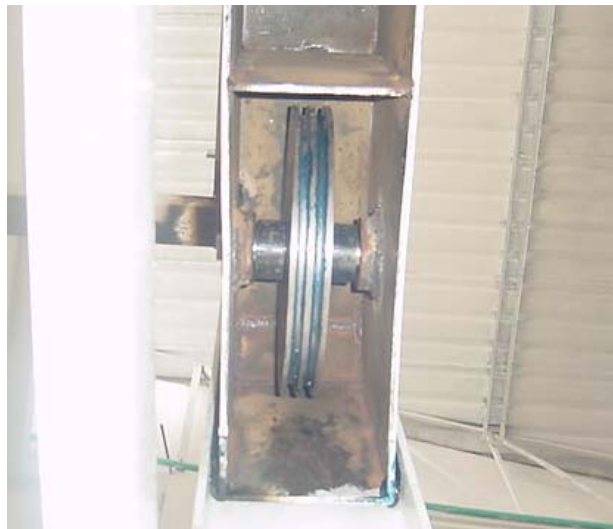
Figura 28. Fotografía del montaje de la polea.
