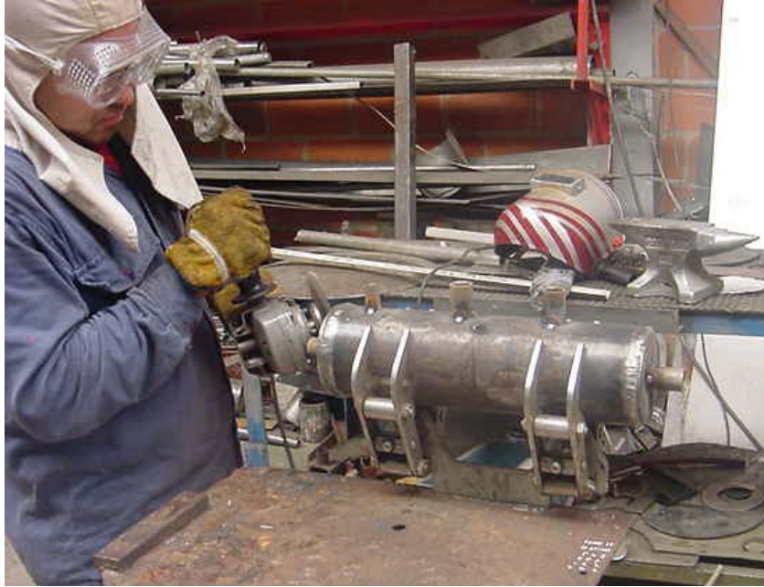
Figura 37. Sistema hidráulico montaje final.
