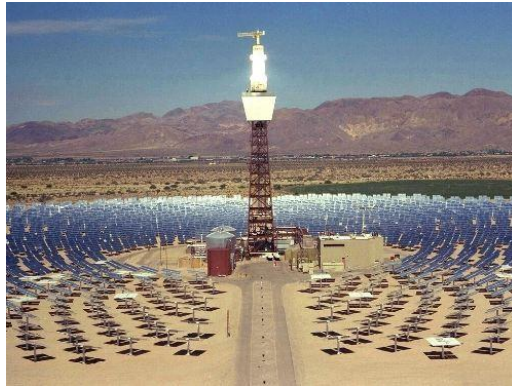
Figura 14. Energía solar térmica
