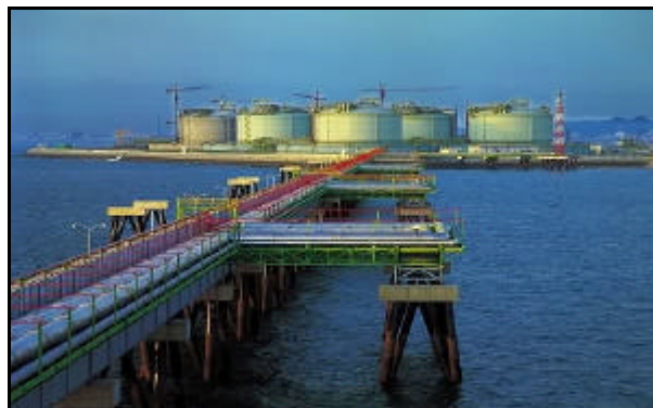
Figura D.11 Configuración de los tanques de almacenamiento en un terminal de regasificación
