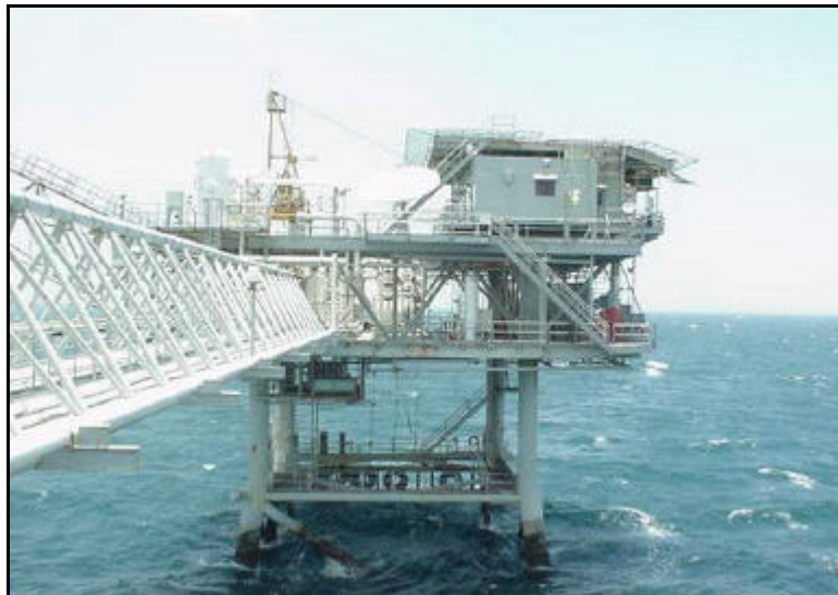
Figura 5. Plataforma de producción y tratamiento de gas natural costa afuera
