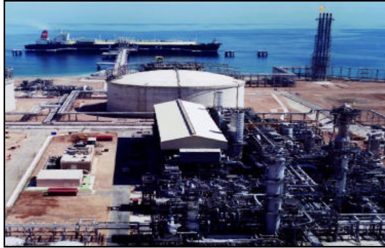
Figura 6. Planta de Licuefacción de Gas Natural Licuado tipo Cascada
