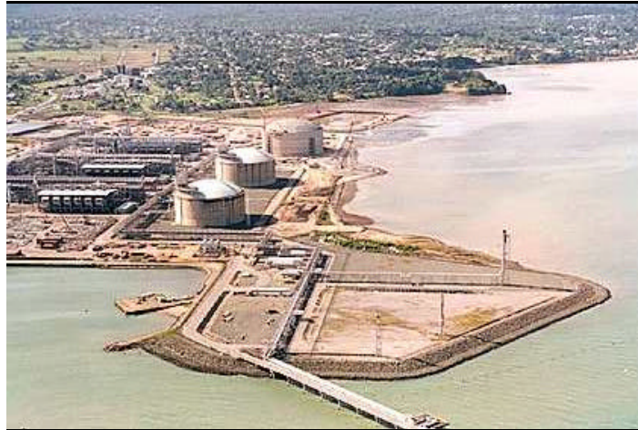
Figura 33. Planta de GNL. Trinidad y Tobago
