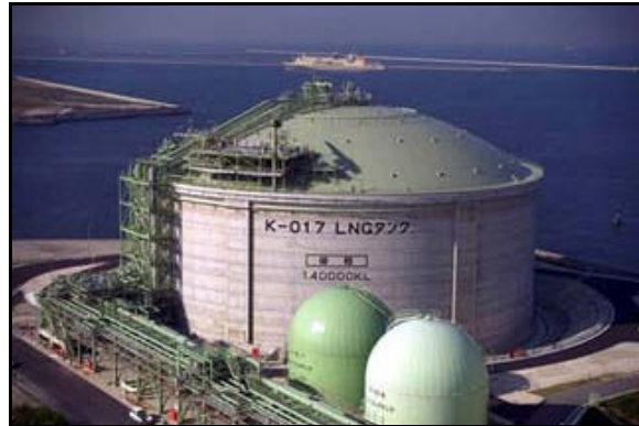
Figura 7. Tanque de almacenamiento de GNL
