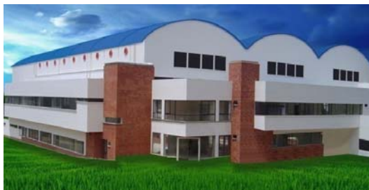
Figura 2. Fachada de las instalaciones de Industrias AVM-GIRON
