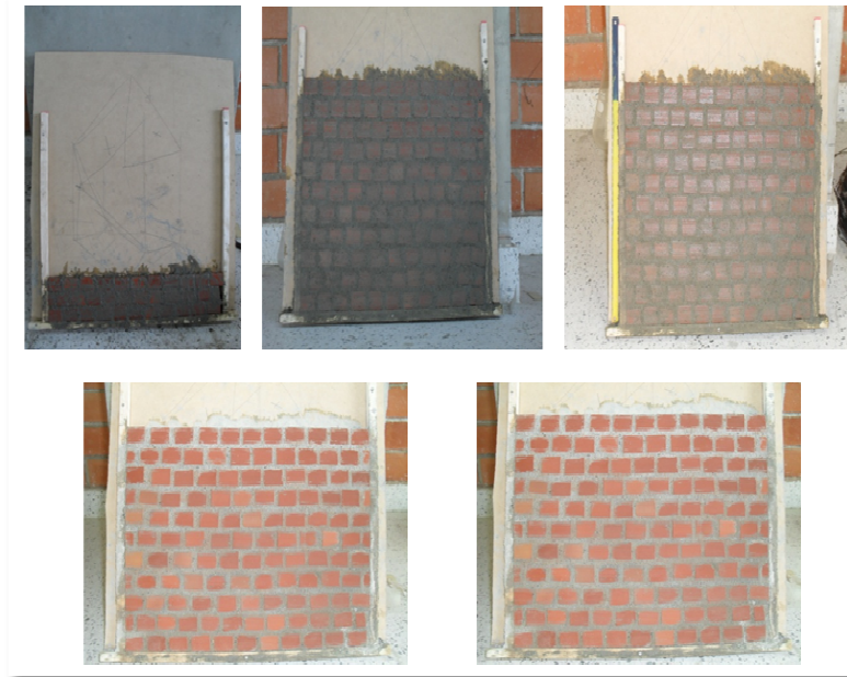
Figura 2. 7 Evolución constructiva del muro de mampostería
