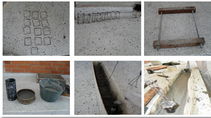
Figura 2. 5 Evolución constructiva de las vigas de unión
