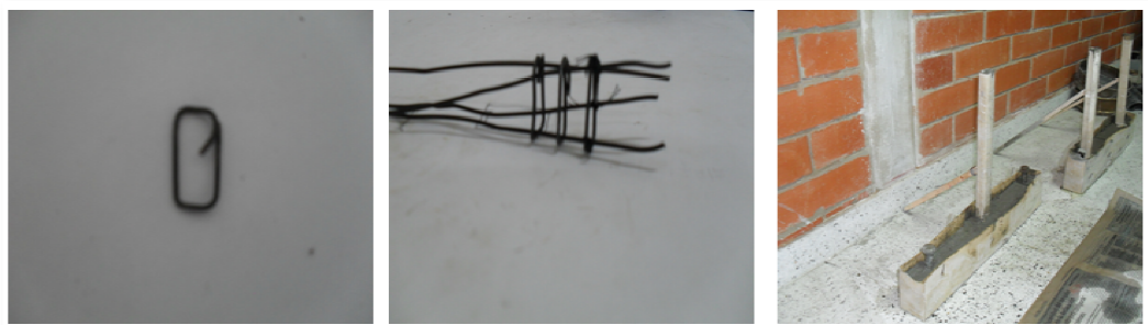
Figura 2. 6 Evolución constructiva de las columnas de confinamiento
