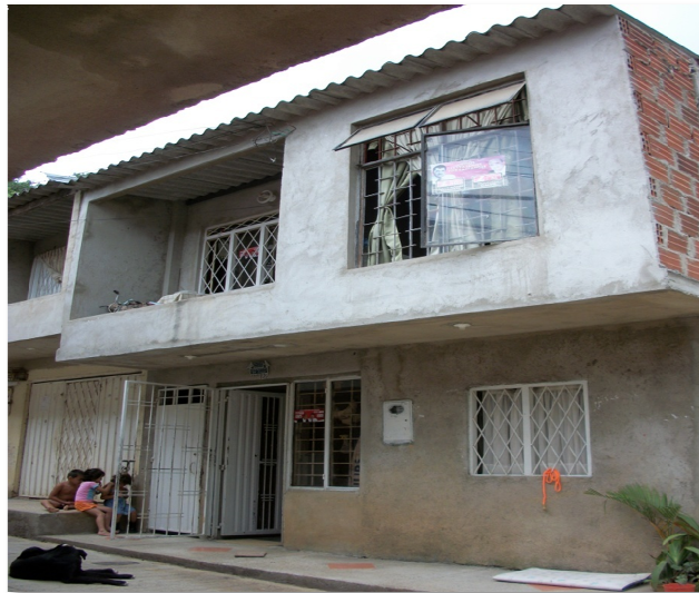
Figura 2. 1 Fotografía de la fachada frontal de la edificación a estudiar.
