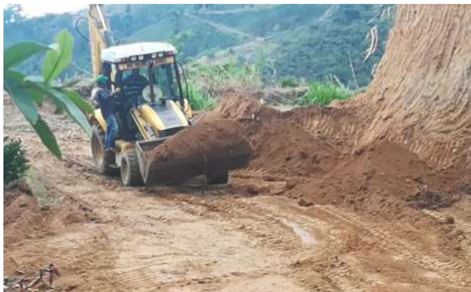
Figura 3. Mantenimiento de vías terciarias.
