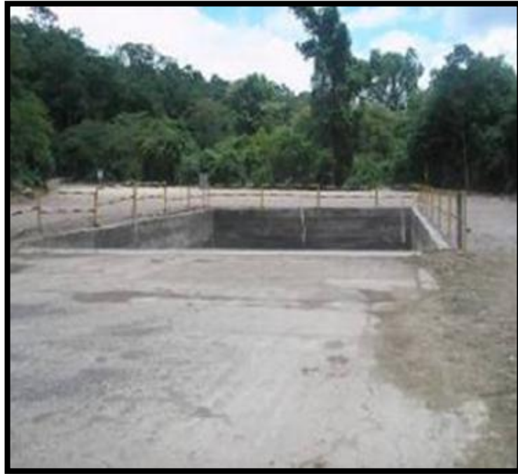
Figura 76. Limpieza del área de reinyección
