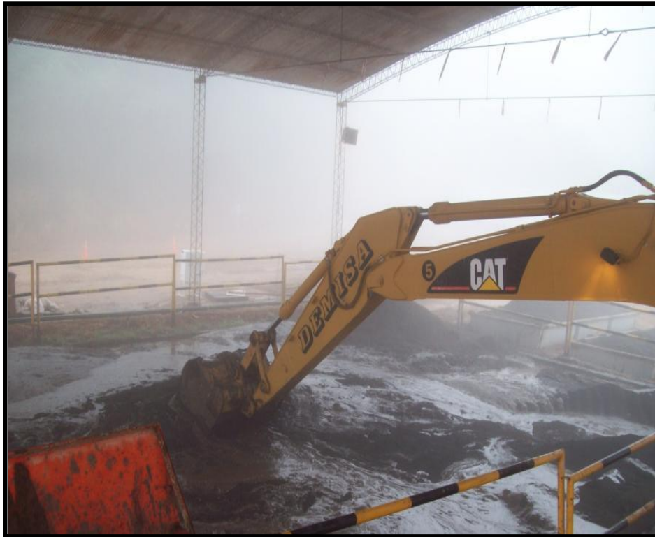
Figura 72. Transporte de los cortes y residuos de perforación
