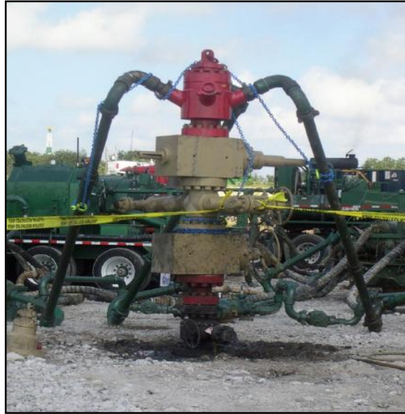
Figura 11. Cabezal de pozo
