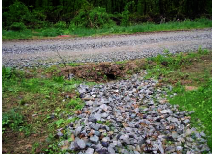
Imagen 12. Estructura de control para aguas pluviales
