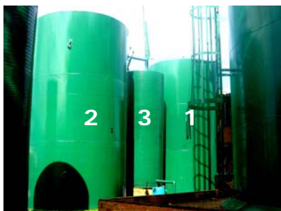
Imagen 4. Tanques Nº 1, 2 y 3
