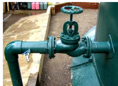
Imagen 1. Tomamuestras Tanque de sedimentación
