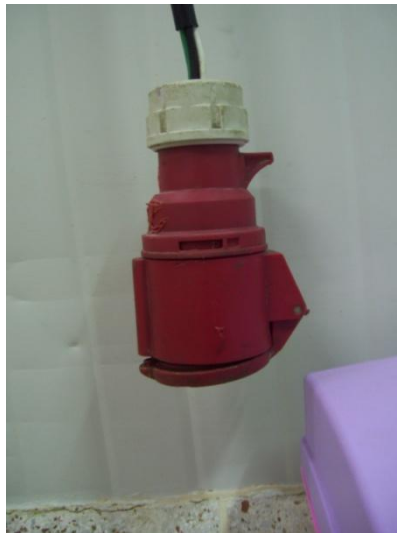
Figura 4–16 Foto 15: conexión eléctrica de cable
