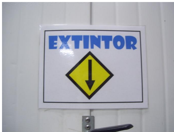
Figura 4 – 12 Foto 11: Señalización extintor hornos carnes frías
