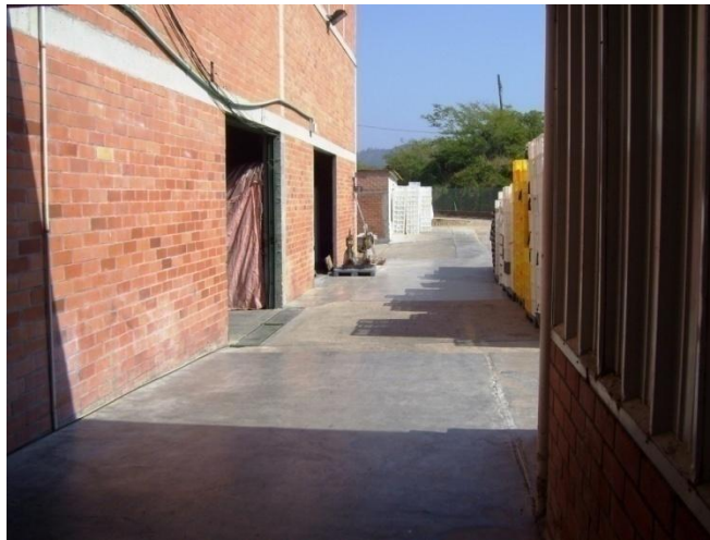
Figura 4–1 Foto 1: Pasillo exterior
