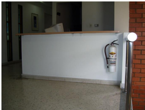
Figura 4–8 Foto 7: Extintor segundo piso oficinas
