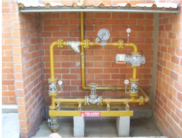
Figura 4 – 23 (Foto 22: Macro-medidor gas natural)
