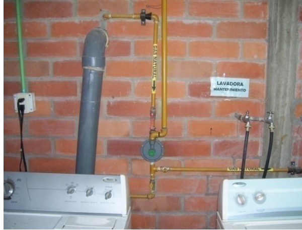
Figura 4–25 (Foto 24: Instalación de gas para las secadoras de ropa en lavandería)
