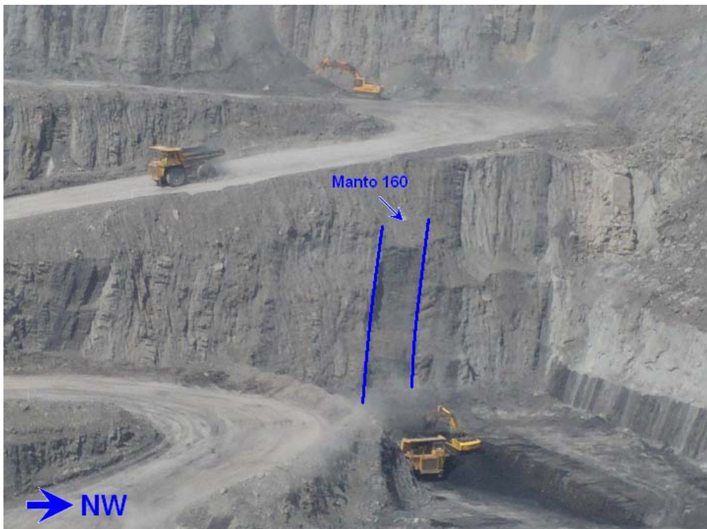
Foto 5. Pared sur del Pit El Hatillo, mayor inclinación de los mantos de carbon, manto 160, parte intermedia a la base del miembro medio de la Fm. Cuervos, en dirección NW.
