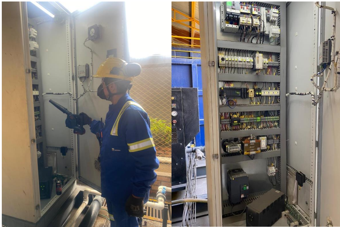
Mantenimiento Tablero Eléctrico
