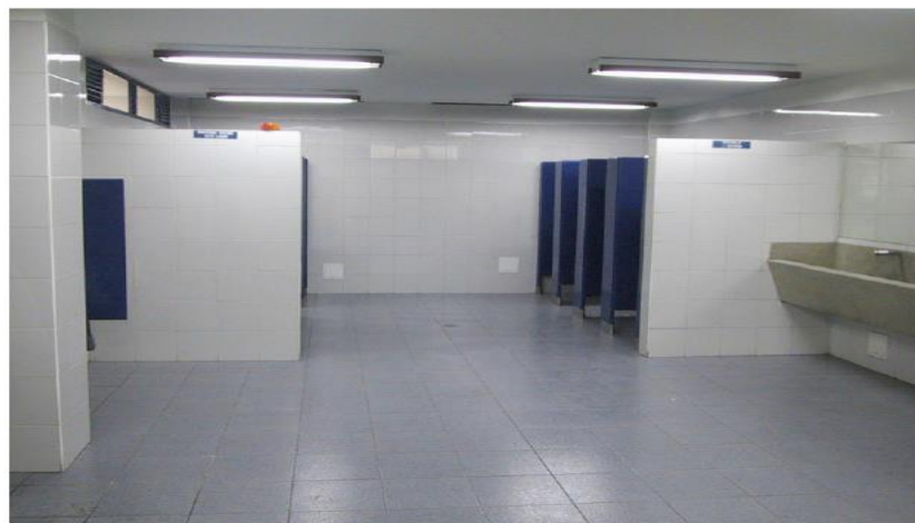
Figura 31. Baños y vestuarios
