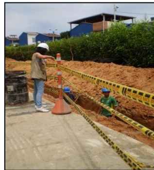
Registro Fotográfico de la obra en el Municipio de Piedecuesta.
