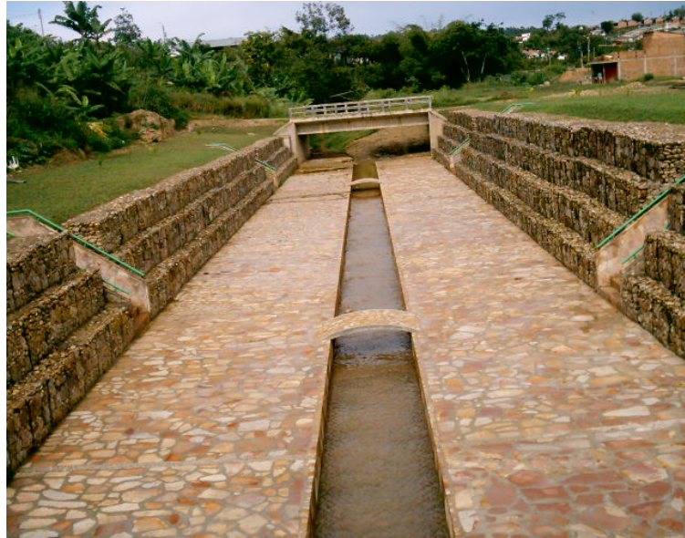
Figura 8. Recuperación de La Quebrada Las Raíces en el Sector 3 comprendido entre las carreras 10 y 12 del Casco Urbano del Municipio de Lebrija
