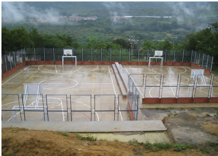
Figura 9. Construcción zona deportiva del colegio San Carlos – Municipio de San Gil
