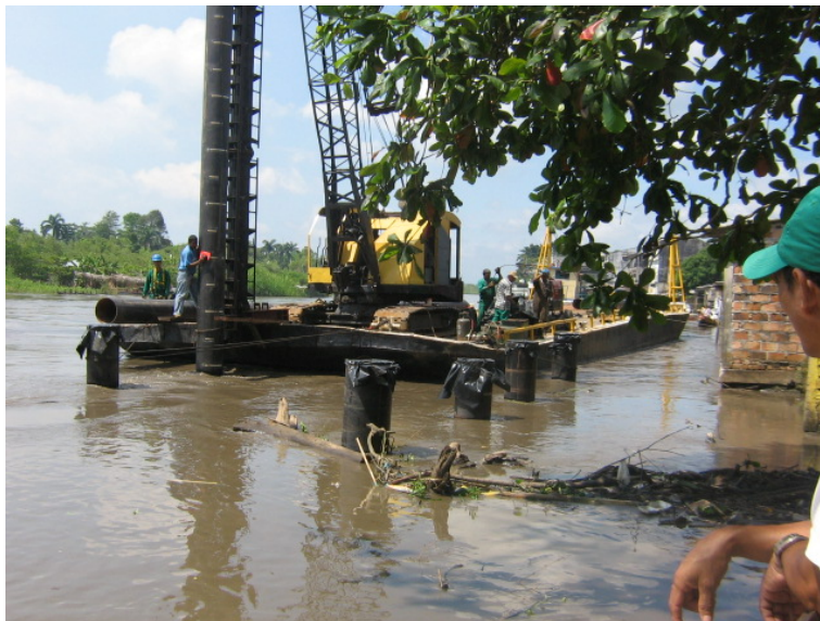
Figura 5. Construcción Muelle - Puerto Barrancabermeja, Santander.
