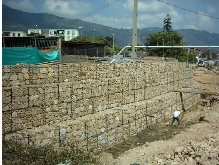
Figura 4. Construcción Muro De Protección En La Margen Izquierda Del Río De Oro Sector Barrio El Poblado Municipio De Girón - Primera Etapa.
