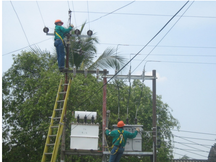
Figura 10. Construcción de redes de alta, media y baja tensión Casino Cantagallo Ecopetrol
