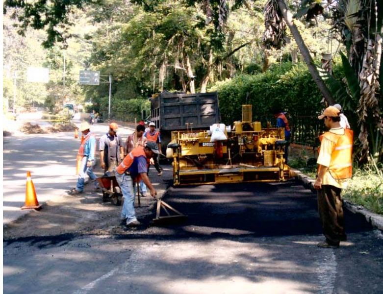
Figura 2. Mantenimiento Vía Antigua (Ruta 45 A - St-13) Bucaramanga - Floridablanca - Cruce 45 A
