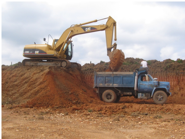
Figura 3. Obras De Protección Contra Inundaciones En El Municipio De Puerto Wilches Sector Perico – Terraplén
