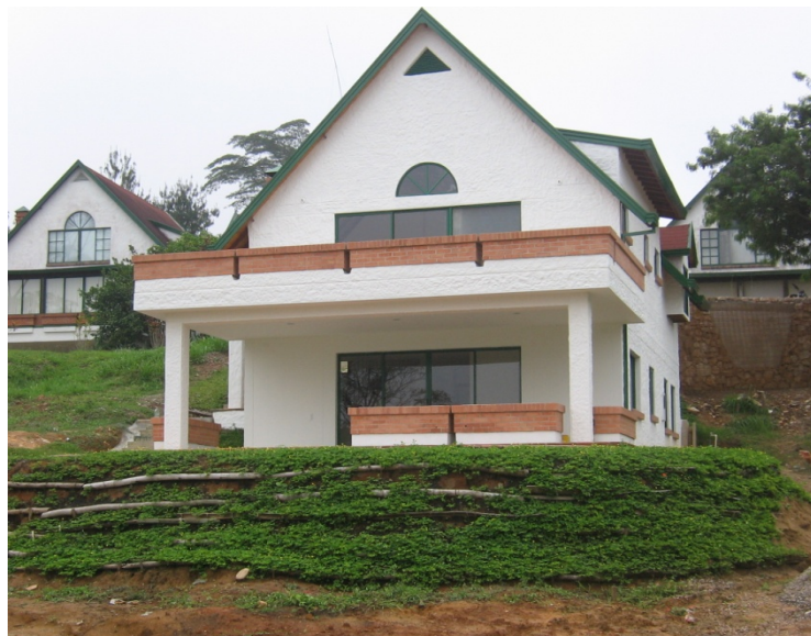
Figura 11. Construcción de cabañas Ruitoque Country Club. Bucaramanga –Santander
