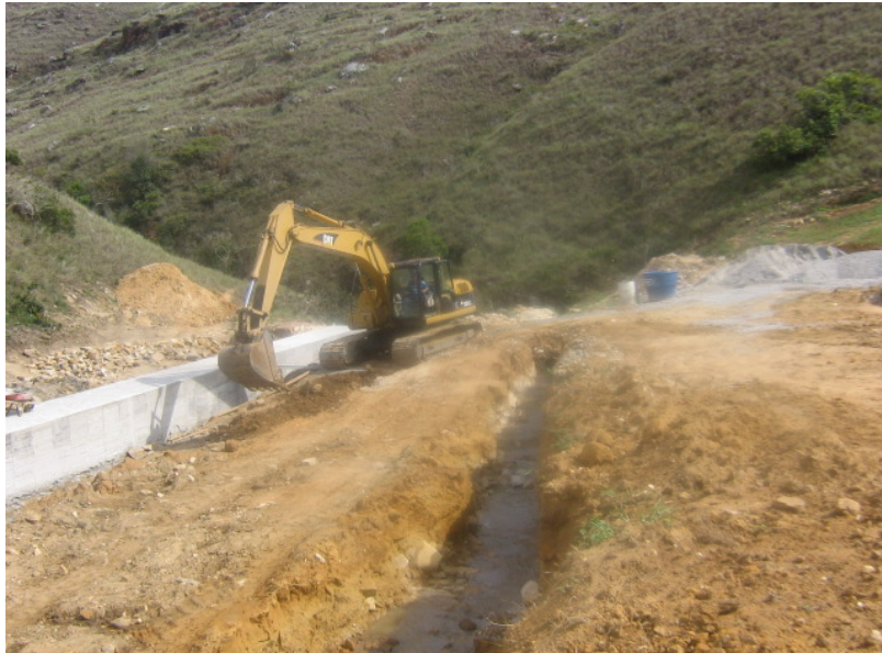
Figura 6. Construcción de Presa Municipio Mesa de Los Santos - Santander
