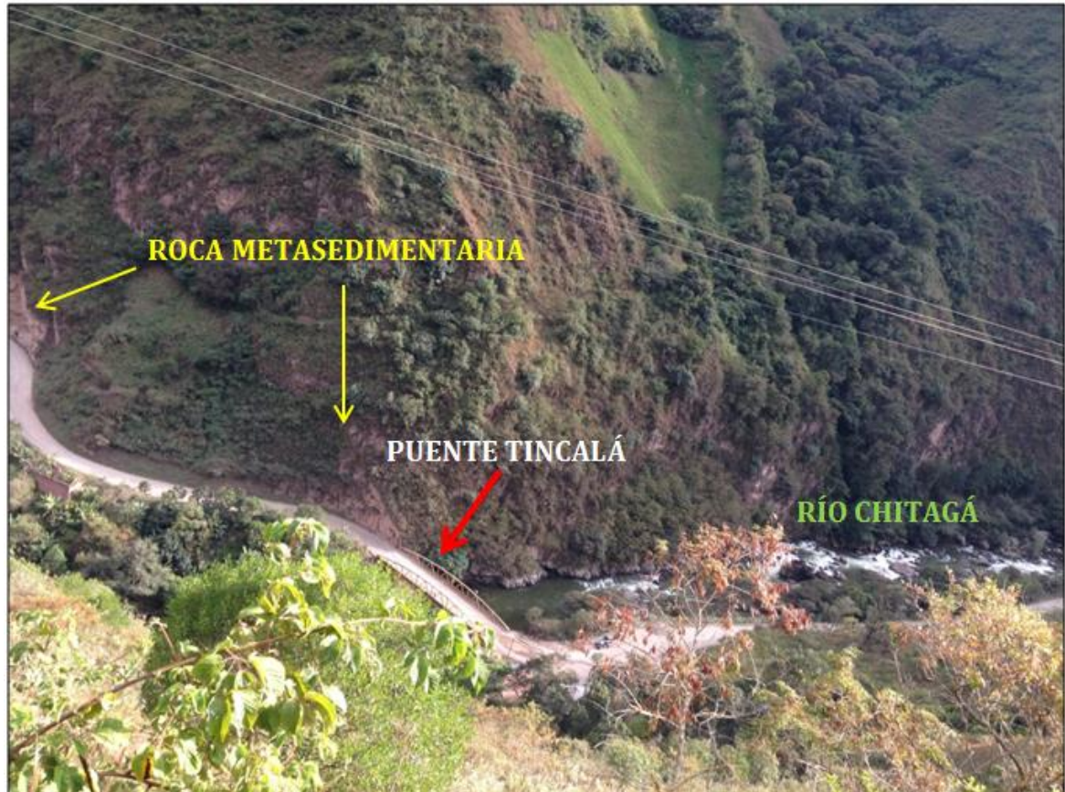
Figura 24. Panorámica del Puente Tincalá, a la altura del Río Chitagá.
