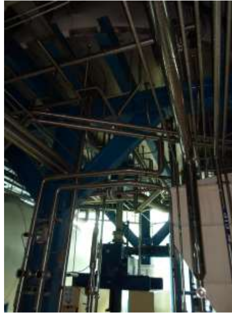
Figura 29. Vista planta baja, entrada de masa por la parte inferior de la olla
