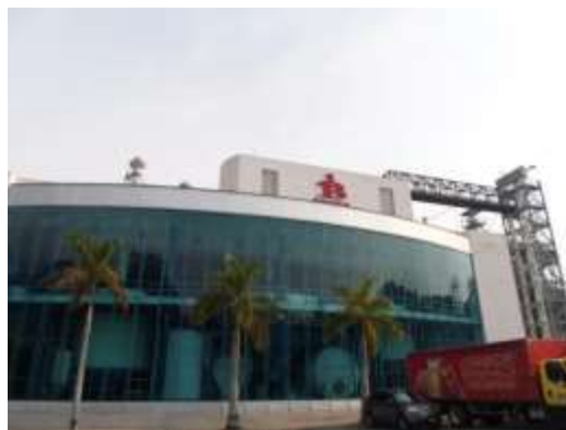
Figura 3. Edificio Elaboración de Productos
