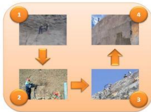
Figura 2. Construcción de pantallas ancladas
