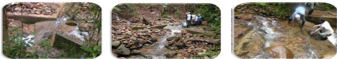
Figura 2. Bocatoma Quebrada la chirigua.
