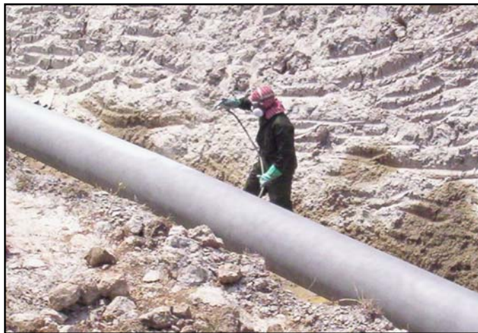
Figura. 13. PK 52+210 – 52+882. Labores de pintura en 100 % sólidos Tomado de un informe del cambio de revestimiento en el gasoducto
